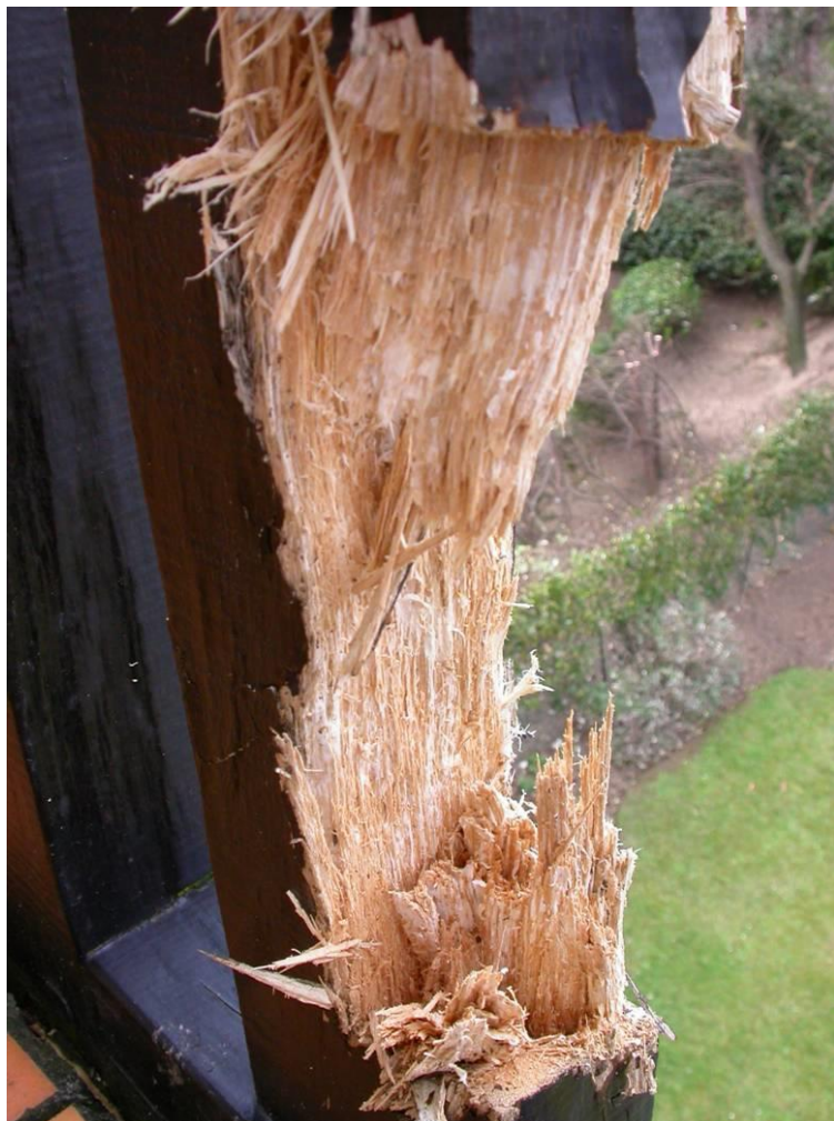
Fig. 2 : Détail de la pourriture fibreuse blanche due à Perenniporia meridionalis
