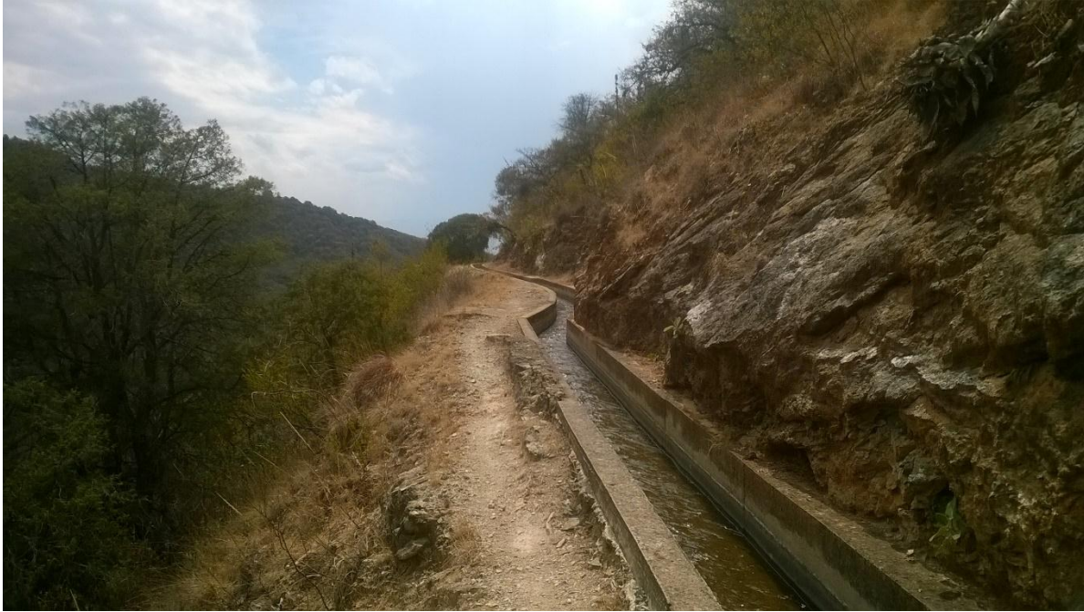
Figura 2-13. Estado actual del canal
