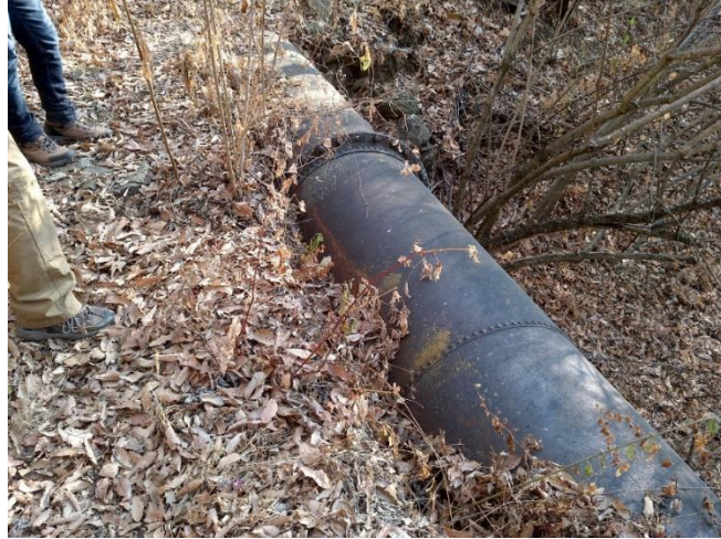
Fig. 2-10. Estado actual de la TF1
