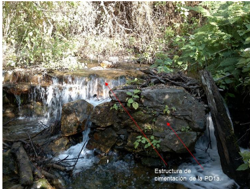
Figura 2-5. Escalón existente que formó parte de la cimentación de la PD1a.
