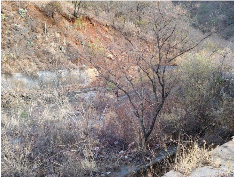
Figura 2-9. Estado actual del TC1
