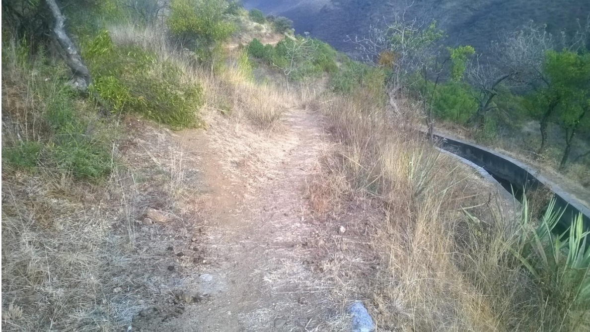
Figura 2-9. Estado actual del canal 1 junto con el sendero.
