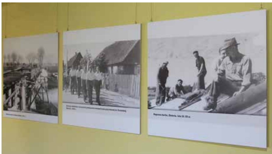
9. Odbudowa mostu w Złotorii, 1941 r.; uroczystość poświęcenia krzyża, 1946 r., fot Adam Zakrzewski
