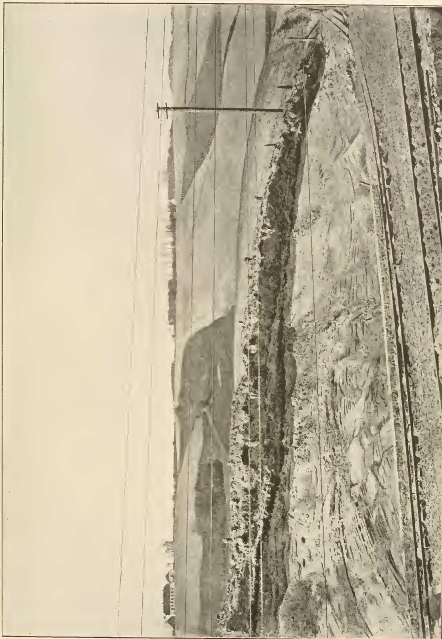
Fig. 26. Ejstrup. Vestlige Ende af Profil B. Terrasse-Sand med meget vekslende Lagstilling. I Baggrunden Bakkerne paa Sydsiden af Kolding Aadalen. Tilhøjre svinger et provisorisk Arbejdsspor ned i Engen. Ved + den naturlige Terrain-Overflade, der er dækket af ca. 1\frac{1}{4} m. opkastet Muld.
