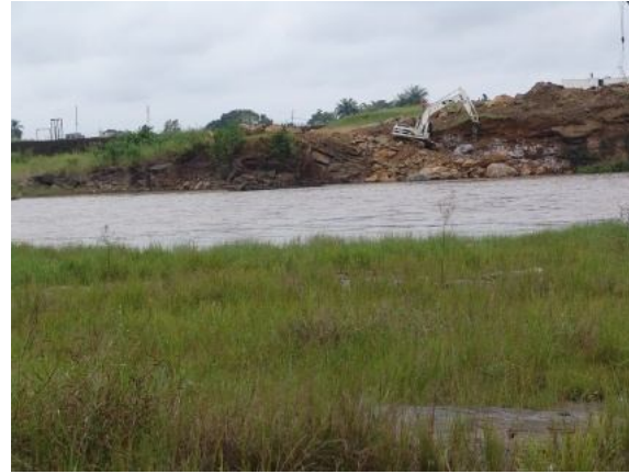
Travaux sur le barrage hydro-électrique d'Edéa Photo: © JP. Ghogue 2008.
