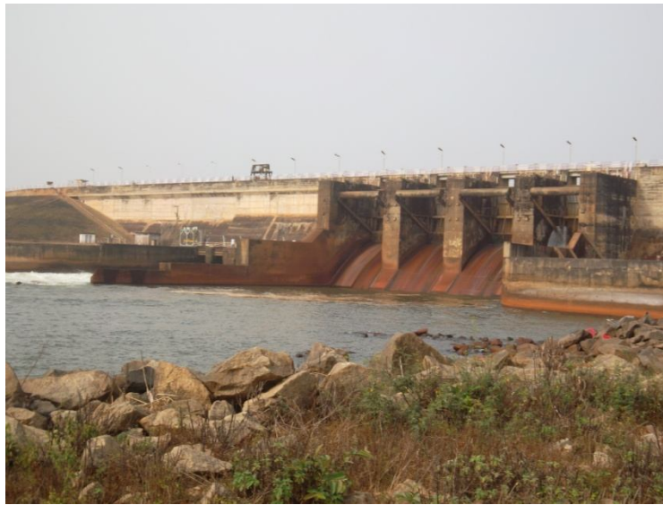
Barrage de Mbakaou, Adamaoua – Cameroun. Photo@JP Ghogue, Janvier 2012.
