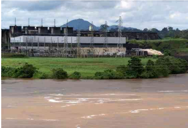
Vue partielle du barrage hydro-electrique d'Edéa. Photo: © JP. Ghogue 2010.
