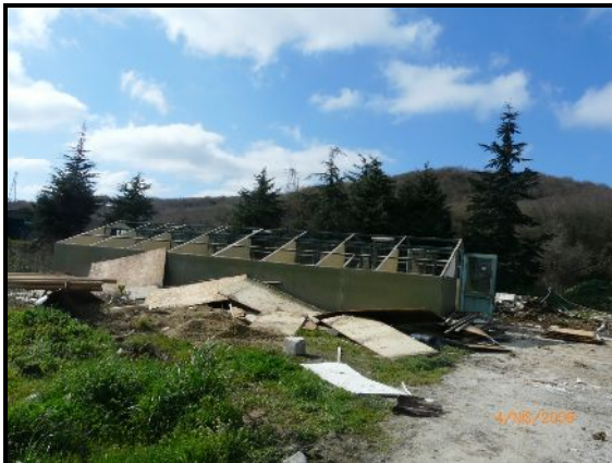
Eski Köpek Barınaklarının Sökülmesi
