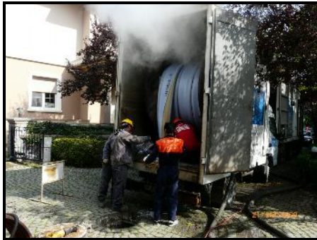
Ekin Sokak'ta Pis Su Hattına Yapılan PVC Kaplaması Çalışmaları
