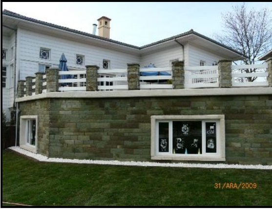
Lokal Dış Cephe Kaplamaları Bakım Sonrası
