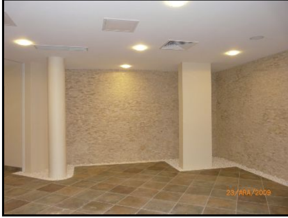
Lokal Bölümü Elektrik Ekibi Çalışmaları
