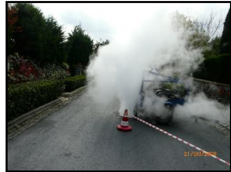
Ekin Sokak'ta Pis Su Hattına Yapılan PVC Kaplaması Çalışmaları
