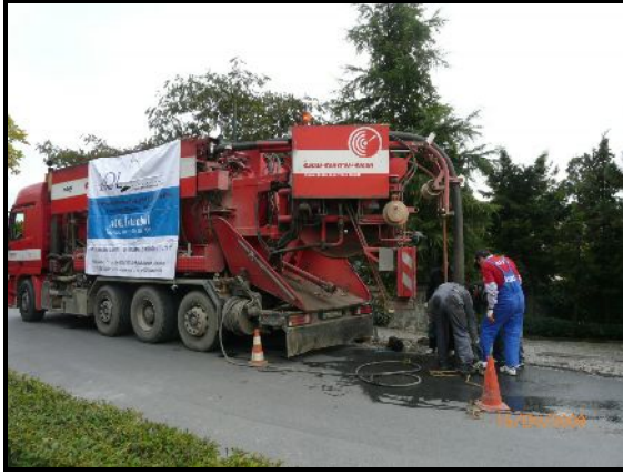
Site Genelinde Yapılan Alt Yapı Temizlik Çalışmaları
