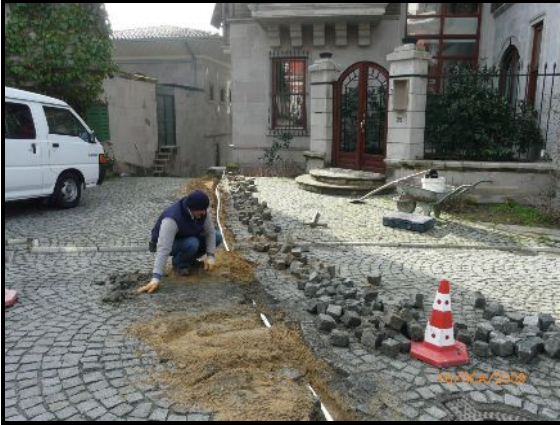
Granit Taş Yollarda Kullanma Suyu Hat Değiştirilmesi Granit Taş Yollarda Su Hattı Değiştirilmesi Sonrası
