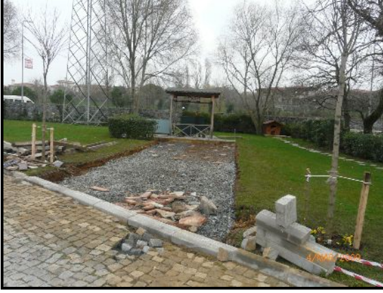
Kemerboyu Girişi Fosseptik Bağlantı Yolu Çalışması
