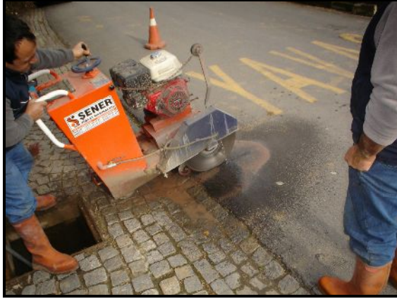
Asfalt Kesme Makinesi Çalışması
