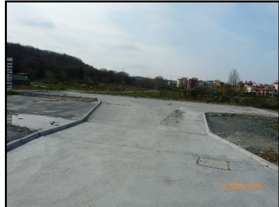
Kemerboyu Sonu Açık Otopark Alanı Bakım Sonrası
