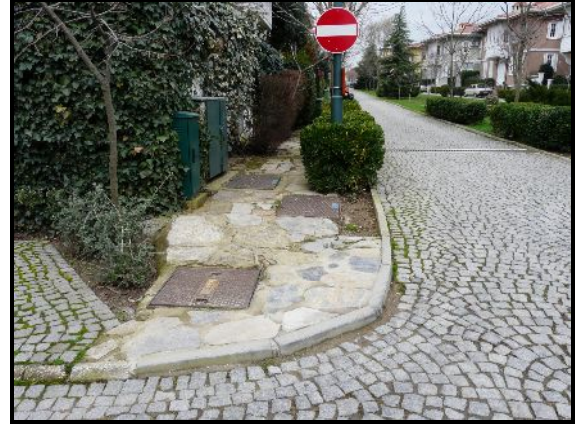
Kayrak taş kaplamaların bakım sonrası
