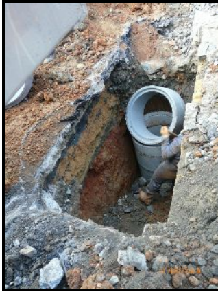
Çöken alt yapı yerine Baca kazısı
