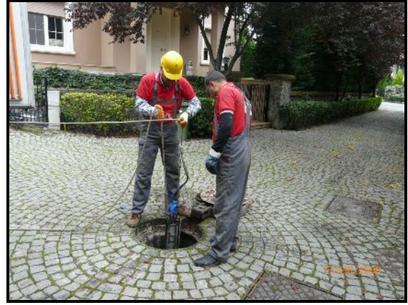
Robot Kamera İle Alt Yapılarda Görüntü Alınması
