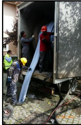
Ekin Sokak'ta Pis Su Hattına Yapılan PVC Kaplaması Çalışmaları
