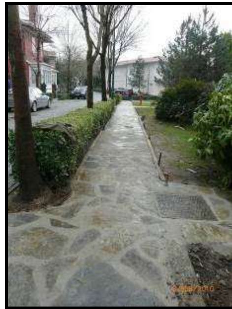
Kayrak taş kaplamaların bakım sonrası
