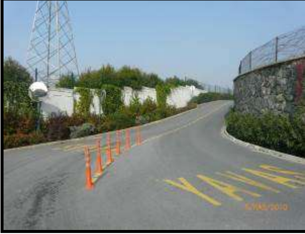
Şantiye kapı ayna
