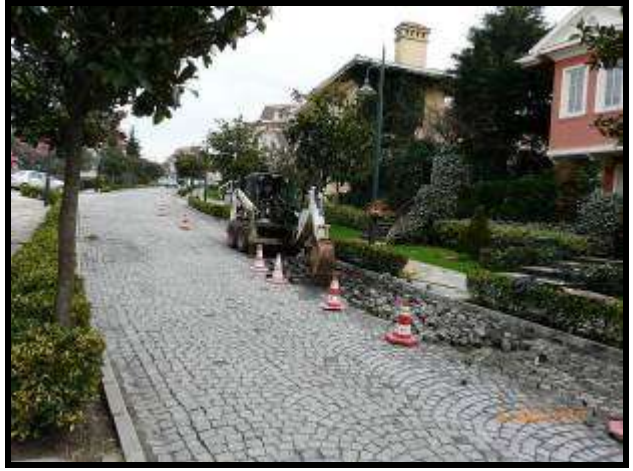
Granit küp taşların Bobcat ile sökümü
