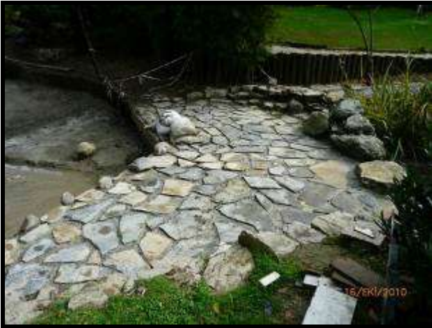
Gölet üzerinden geçiş kayrak yapımı
