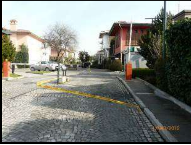
Ana Kapı – Köy Meydanı arası çöken yerler
