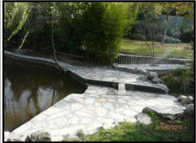
Gölet üzerinden geçiş kayrak yapımı
