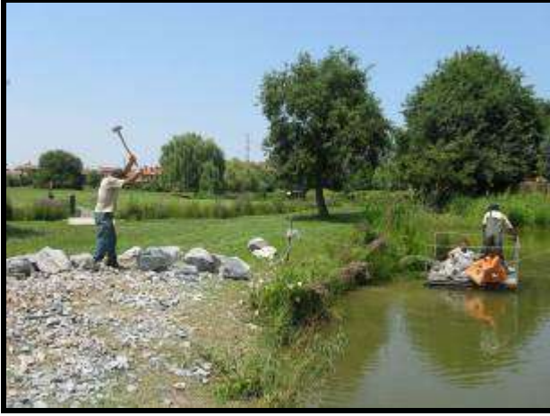
Taşların Balyozla kırılması ve salla taşınması
