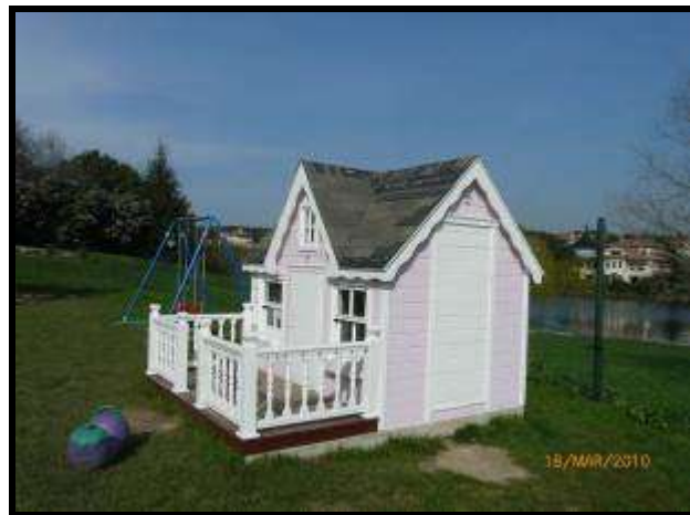
Kırılan kapının onarımı
