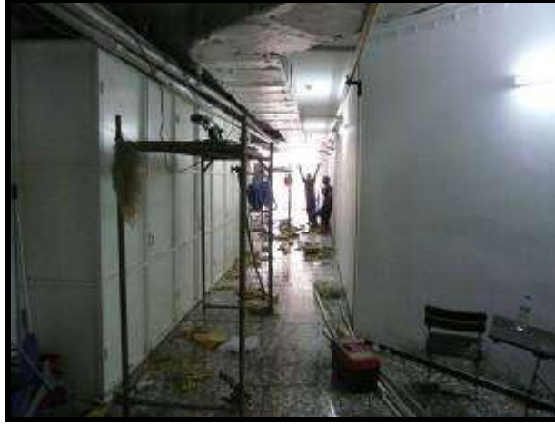
Sıcak – Soğuk su borularının değişimi
