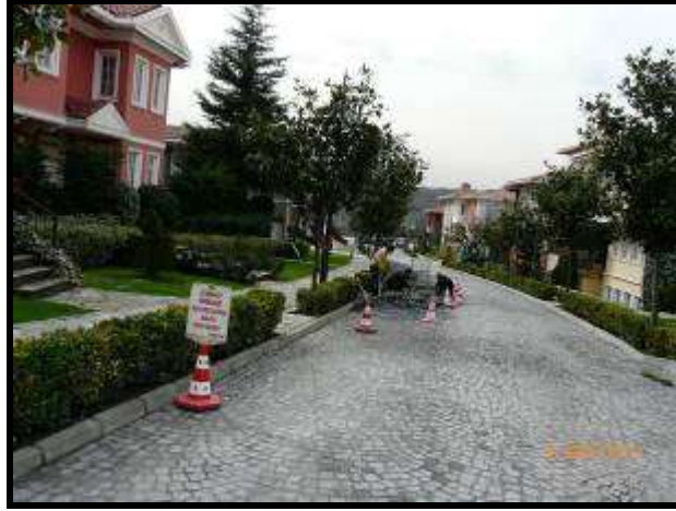
Granit küp taşların yapımı
