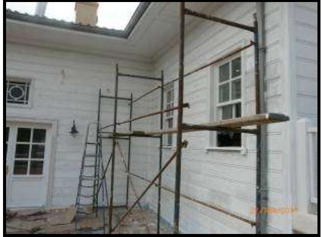
Zımpara ve Boya yapılması
