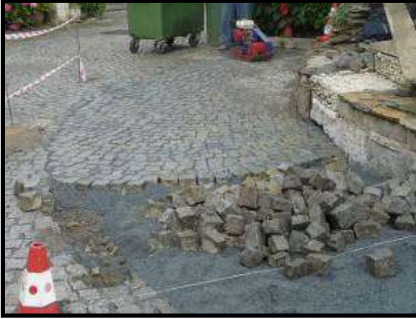
Granit küp taş döşenmesi
