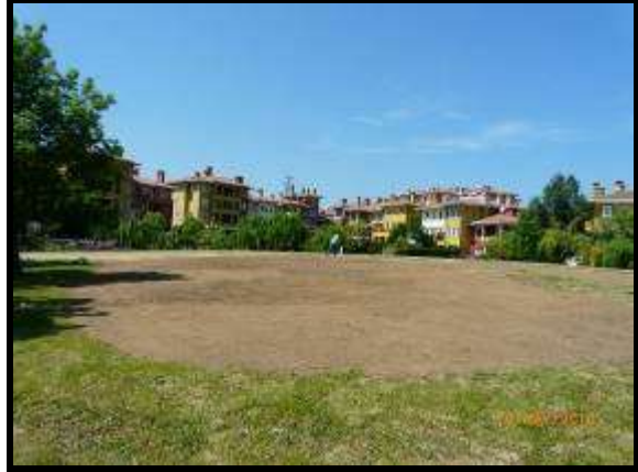
Tesviye yapılması ve tohum atılması
