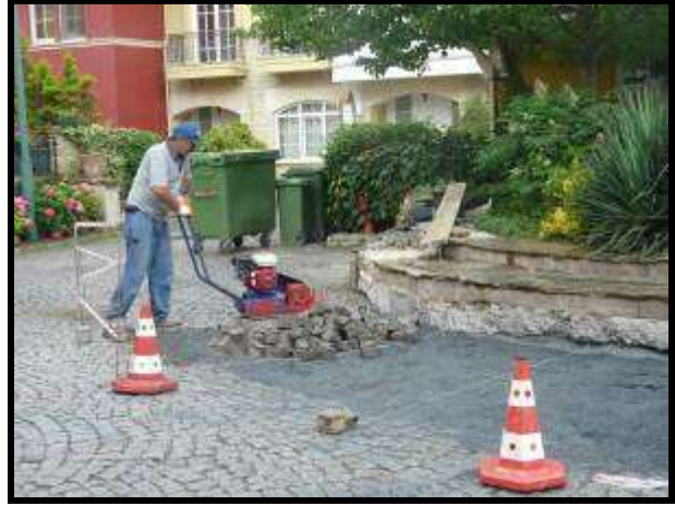
Granit küp taşın kompaktörle sıkıştırılması
