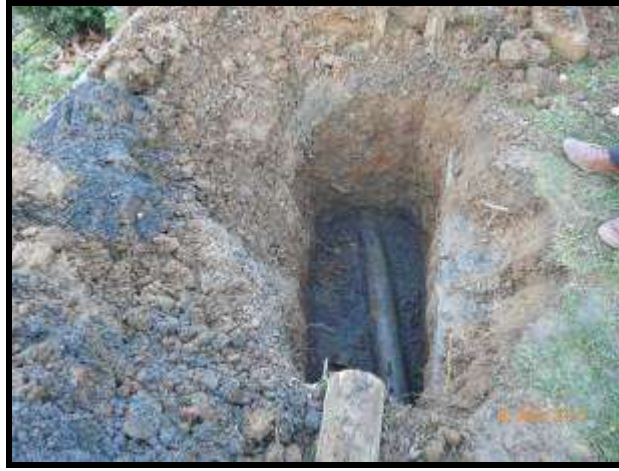
Bahçe Sulama Ana Hat patlak boru tamiri
