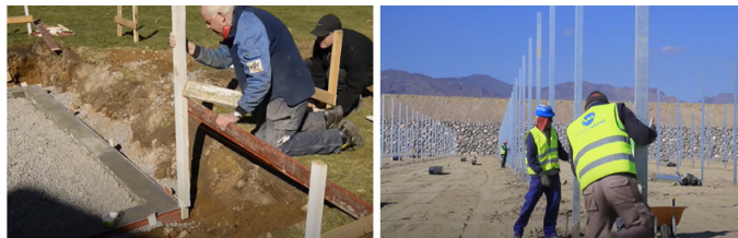
Görsel 4.3: Sera temel kazıklarının çakılması
