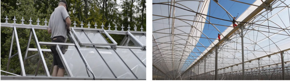
Görsel 4.8: Havalandırma pencerelerinin yapılması
