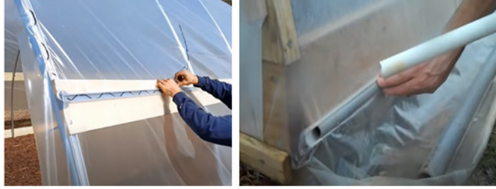
Görsel 4.14: Serada plastik örtünün kısıkaç ile tutturulması
