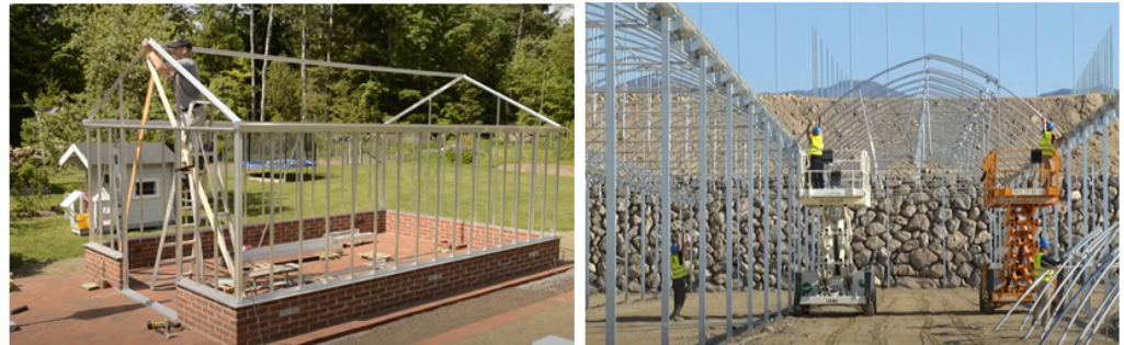
Görsel 4.7: Sera kolon ve makaslarının bağlanması
