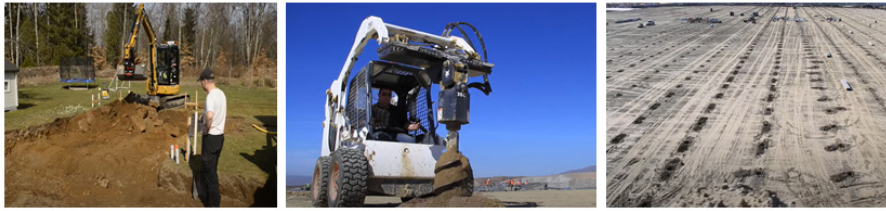
Görsel 4.2: Sera temel çukurlarının açılması
