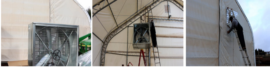
Görsel 4.18: Serada mekanik havalandırma sistemi kurulumu
