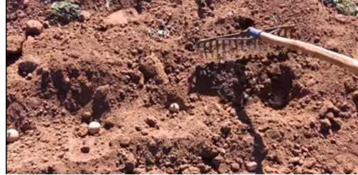
Görsel 2.89: Toprakla kapatılması
