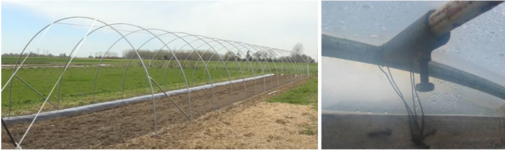
Görsel 3.27: Yüksek plastik tünellerde üst noktaların birleştirilmesi ve bağlanması
