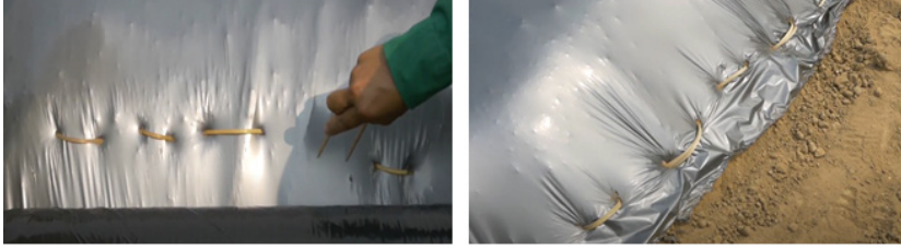
Görsel 3.18: Yüzeysel örtü materyalinin kenarlarının klips ile tutturulması
