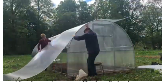
Görsel 4.11: Seranın polikarbon ile kaplanması
