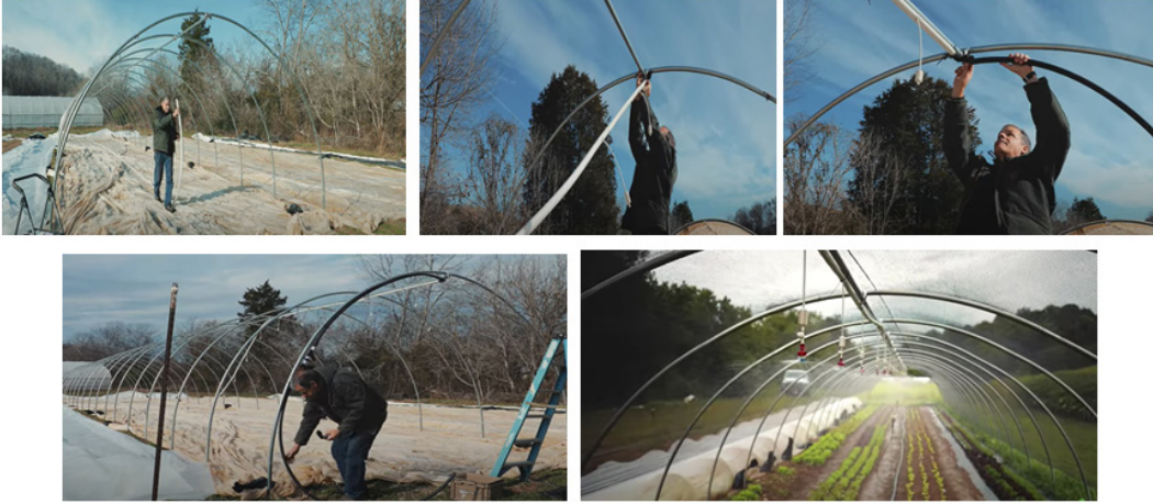
Görsel 4.34: Serada yağmurlama sulama sistemi kurulumu
