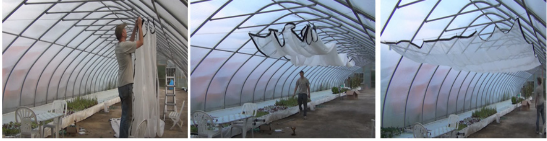
Görsel 4.26: Sera içerisinde gölgeleme perdesinin takılması
