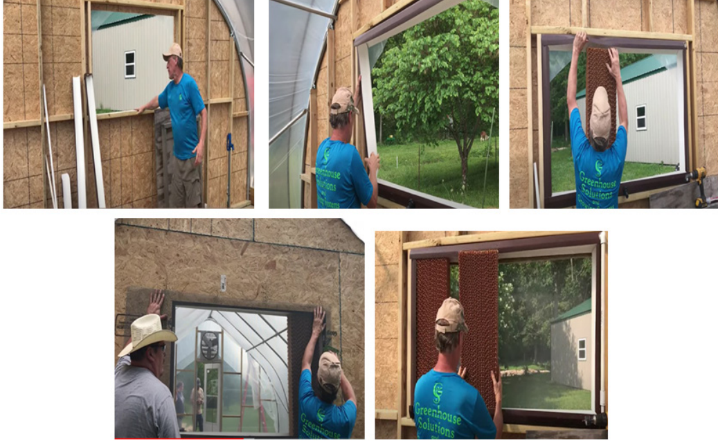
Görsel 4.32: Soğutma yastıklarıyla soğutma (Fan-pad sistemi) sisteminin kurulması
