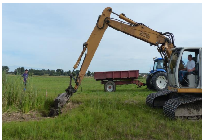
1- Décapage des plaques de Littorelle en bord de mare.
