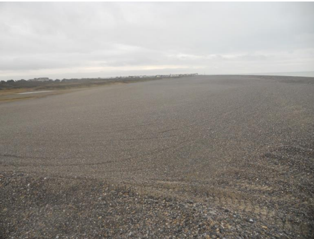
Plateforme SILMER juste après renaturation - 01/2014.
