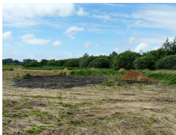
Travaux de dessouchage et broyage – 2012.
