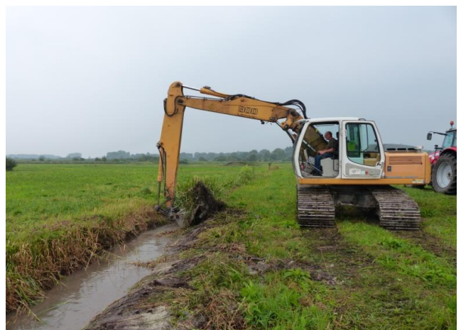
8- Fossé pendant la restauration.
