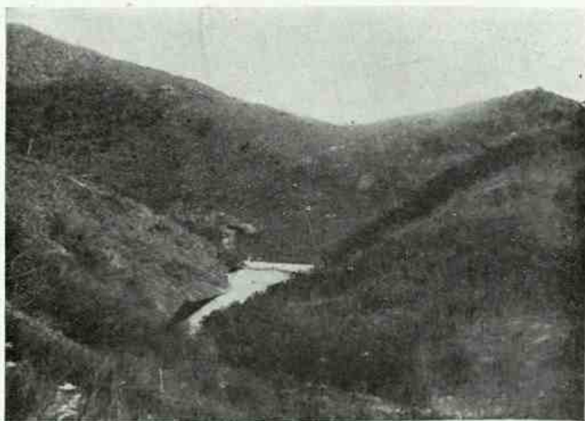
Fig. 6 — O poço por cima da Cachoeira da Fumaça
