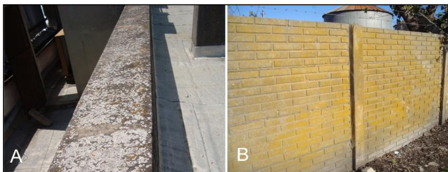
Figura. IV.2. A= muro horizontal colonizado por líquenes; B= muro vertical colonizado por líquenes
