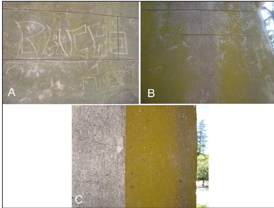
Figura IV.3. A= muro donde se uso los especios dejados por la limpieza de líquenes como grafitis; B= Marcas de gasterópodos que se alimentaron de los líquenes; C= sector a la izquierda hidrolavado, sector a la derecha no hidrolavado
