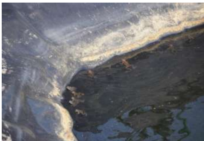
Fot. 22. Żaby i ropuchy nie mogące opuścić zbiornika wodnego po okresie godowym ze względu na strome, wyłożone folią ściany
