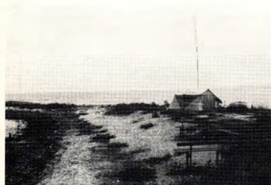
Her ses teltet med 80-meter stationen. Antenne til højre er en FD-4 dipol og til venstre ses en vertikal antenne (den stod i vand da vi rejste den - men i mellemtiden er det blevet lavvande).
