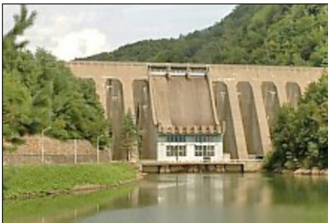
Fig.1. Barajul Stâmtori Firiza (tetainfo@welcometoromania.ro)
