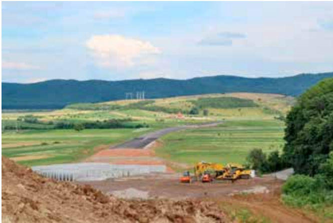
Fig. 2. Construcția unui ecoduct pe traseul coridorului ecologic la autostrada LUGOJ – DEVA (Foto Flaviu Vodă)
