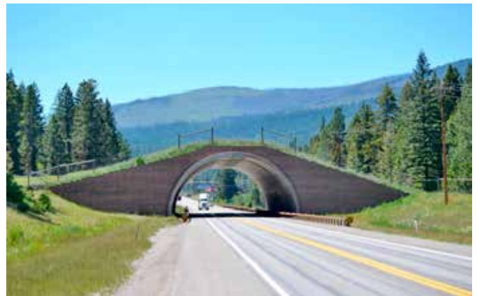
Fig. 4. Ecoduct finalizat – Statul MONTANA, SUA (Foto Flaviu Vodă)
