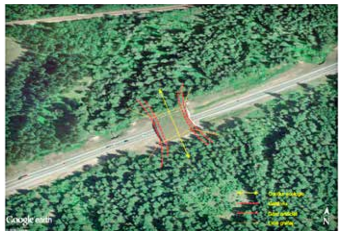
Fig. 5. Ecoduct amplasat pe traseul coridorului ecologic (Google Earth)
