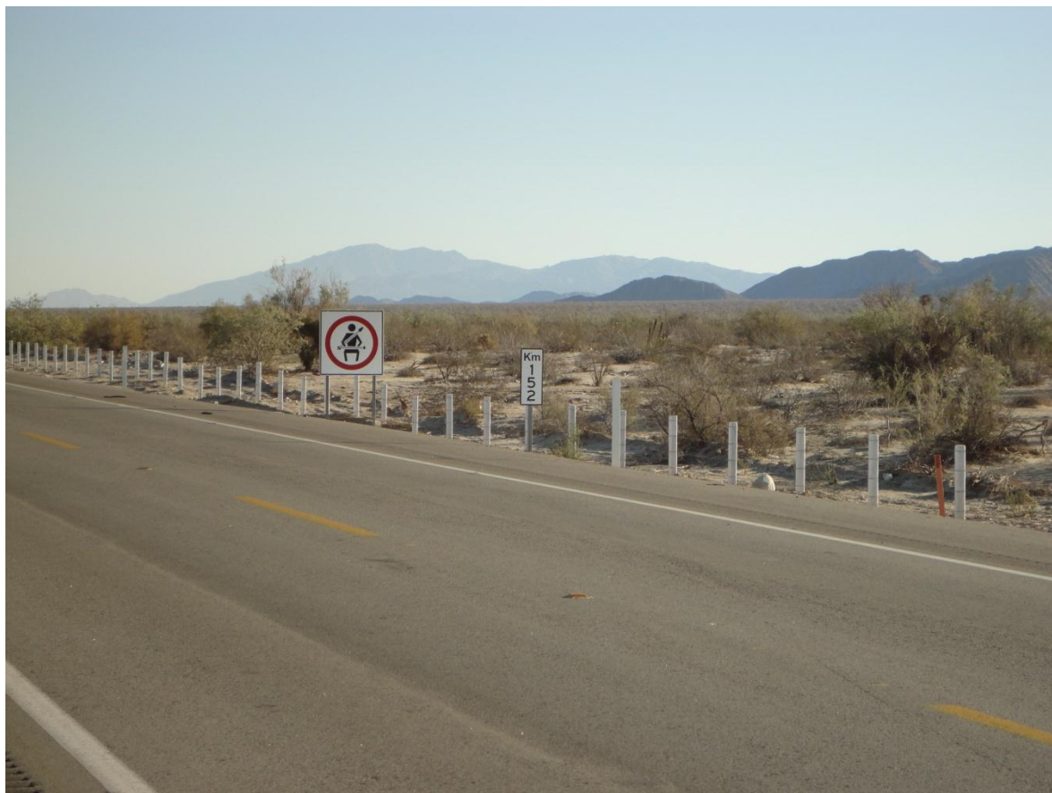
Figura 4. Señalamiento para localizar el camino de acceso actual al sitio del proyecto.
