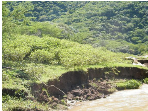
Figura 58. La falta de vegetación ocasiona erosión y derrumbes del suelo, afectando el cauce del río.
