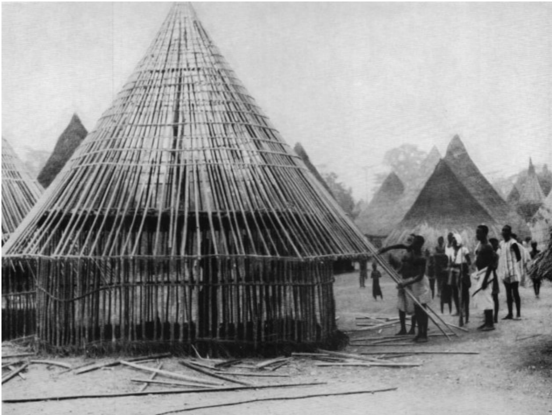
Abb. 6A: Hausgerüst. Das Dach wird mit Gras oder mit Palmblättern gedeckt, die Wände werden mit Lehm beworfen
