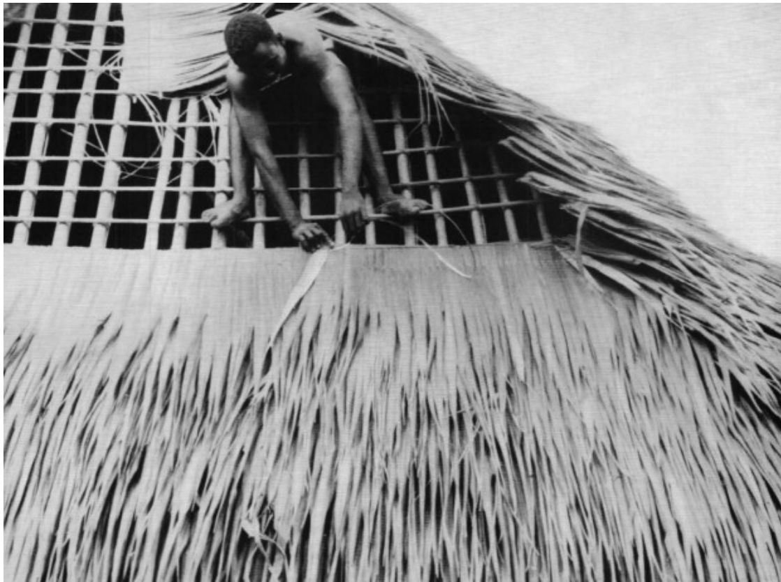
Abb. 6B: Dadldecken. Palmblätter sind leichtter zu verarbeiten als Gras, aber weniger haltbar. Fig. 6B: Thatching. Palm leaves are easier to work with than grass, but are less durable.
