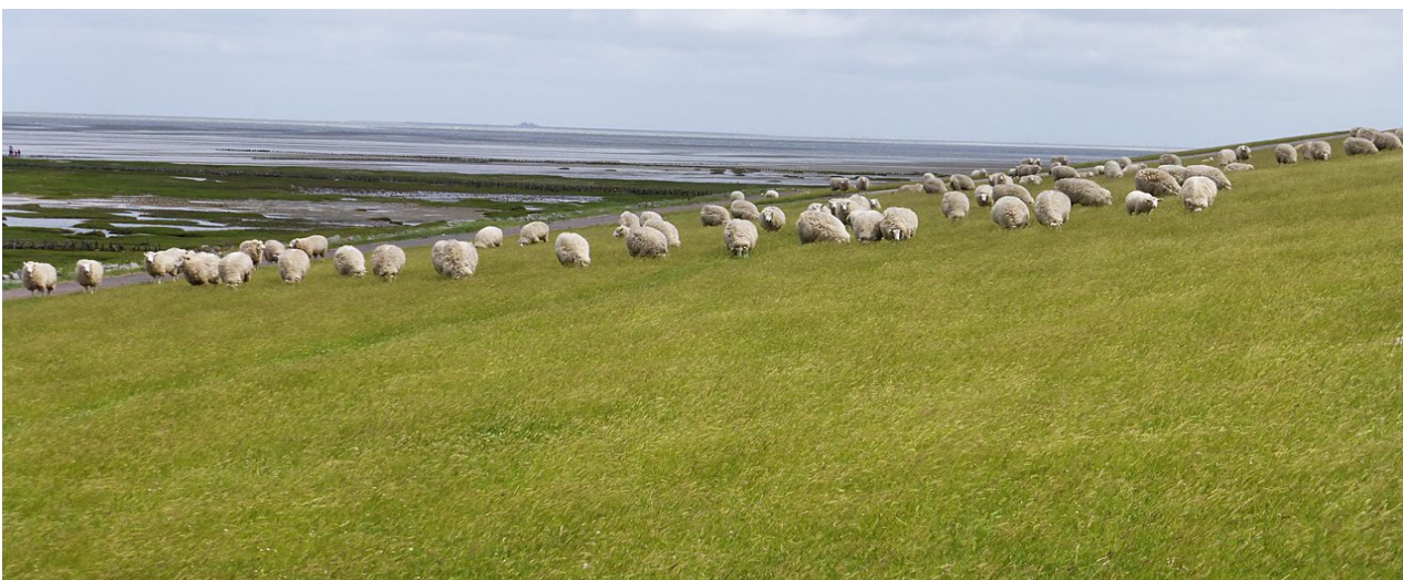
Abb. 4 Außenböschung eines intensiv beweideten Seedeiches (Nord-Westerhever/Eiderstedt, am Horizont Hallig Südfall/Rungholt) als Beispiel eines Deiches, dem seeseitig keine Salzwiesen vorgelagert sind (Schardeich). Der Deichfuß ist seeseitig durch eine etwa 1–2 m hohe Steinpackung gesichert. Vegetation: Lolio-Cynosuretum cristati mit Beimischungen von u.a. Hordeum secalinum , Holcus lantus , Festuca rubra , Bromus hordeaceus , Elymus athericus (hier bis 12 Grasarten)
