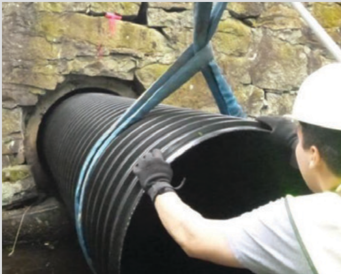
39 foot PE x PE 36" Kanapipe slip line Mendon, MA
