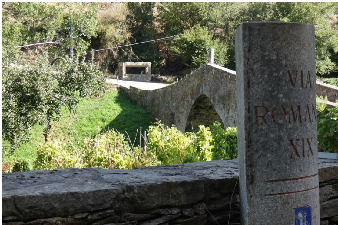
Ponte nas Pontes de Gatín (Becerreá).
