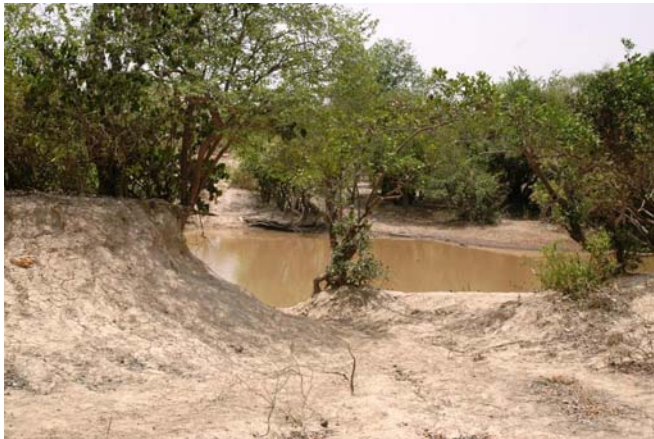
Figure 30. Dégradation et érosion des berges le long de la Koba, à Dounonso. (Photo Laurent Granjon)
