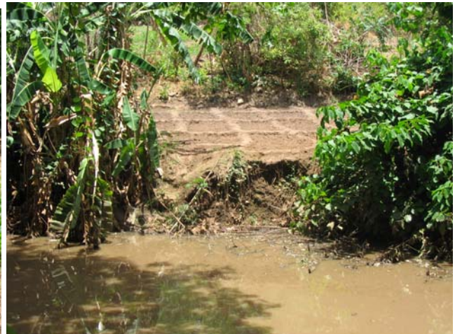
Figure 21. Effondrement des berges
