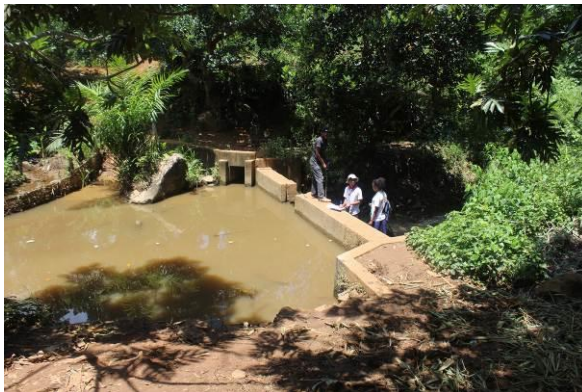
Photo 8 : Barrage à Ampahibe
