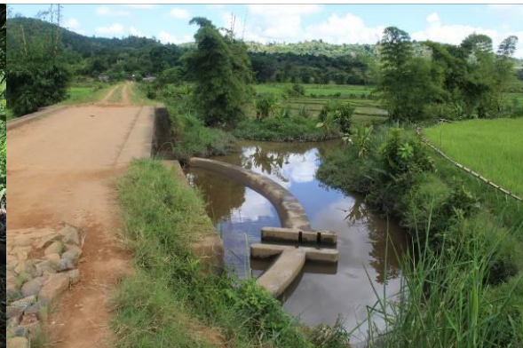
Photo 9 : Barrage en voûte sur la rivière d'Izafo
