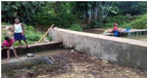
Photo 21 : Petit barrage de dérivation d'une partie de l'écoulement de la rivière
