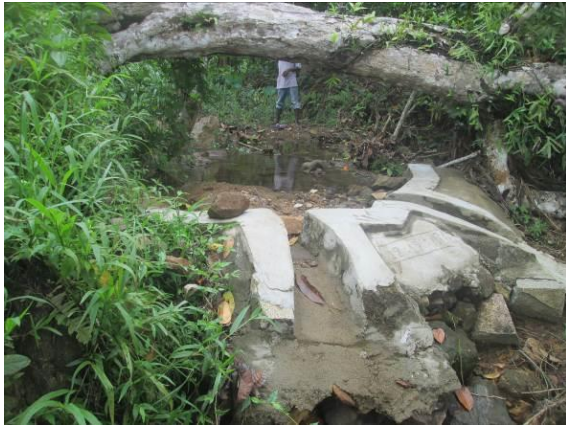
Photo 16: Captage de ruisseau du périmètre de Sahalonjy à Manompana
