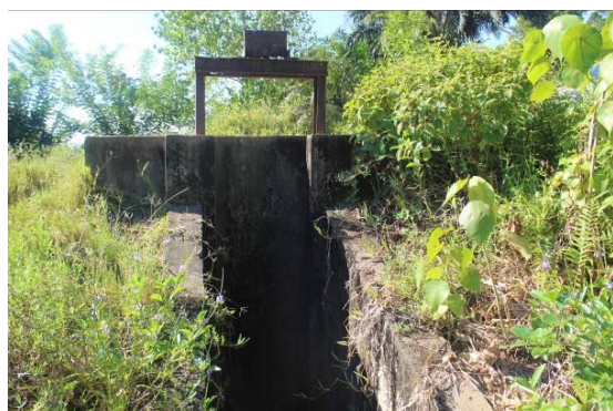
Photo 7 : Vanne vandalisée et support de fixation rouillé
