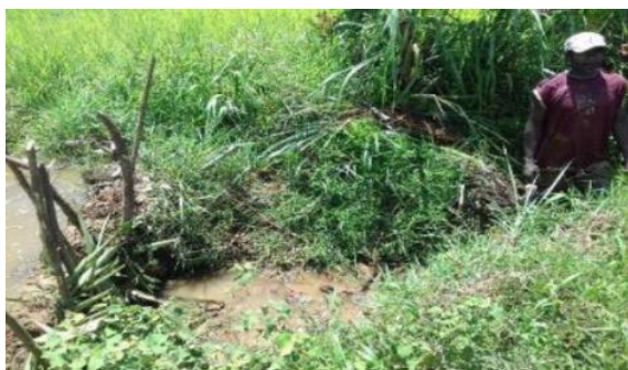
Photo 19: Captage de source par une technique traditionnelle
