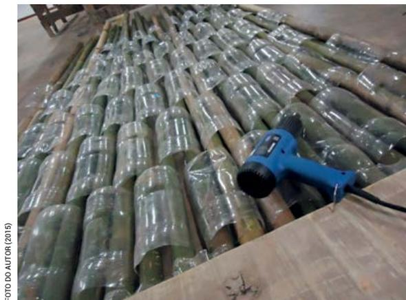
Figura 3. Etapa de montagem de painel com embalagens PET de 2 litros, anterior à conformação térmica. Detalhe do soprador de ar quente
