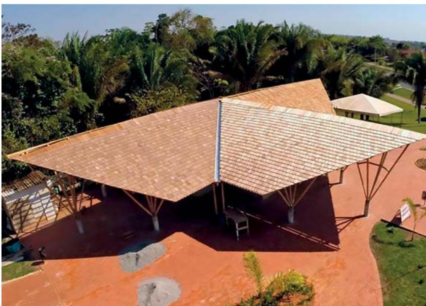
Figura 4. Imagem aérea do quiosque de bambu com a telha de cavaco, projetado com cinco águas e em formato triangular
