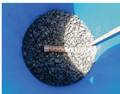
(B) Recobrimento do tubo com brita # 1
