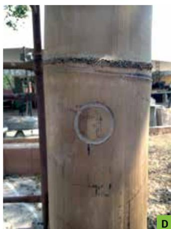
Orifícios fechados após aplicação do graute nos pilares
