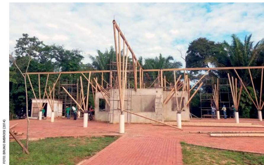
Figura 2. Imagem da estrutura inicial do quiosque mostrando os bambus presos aos pilares de concreto
