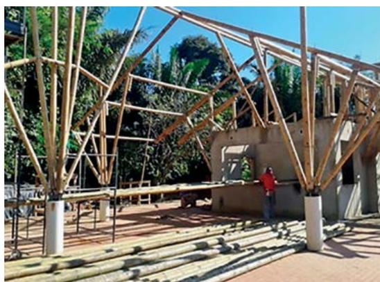
Figura 5. Estrutura dos pilares de concreto e bambu para estrutura da cobertura do quiosque
