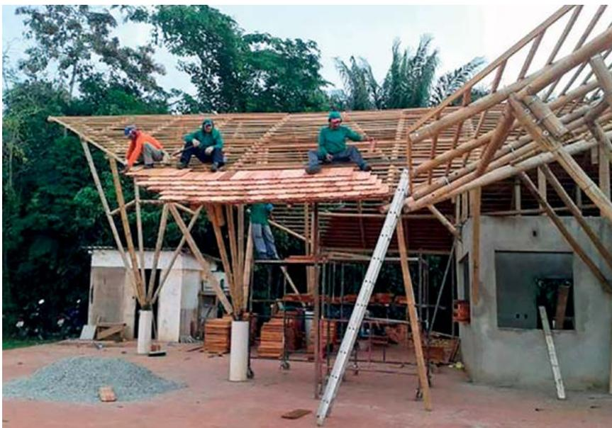
Figura 3. Colocação da telha de cavaco na cobertura do quiosque
