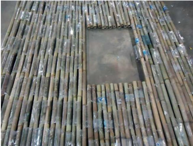
Figura 4. Uso dos painéis em parede com abertura após conformação térmica
