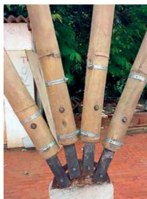
Figura 6. Conexão do pilar de concreto com os bambus estruturando a cobertura
