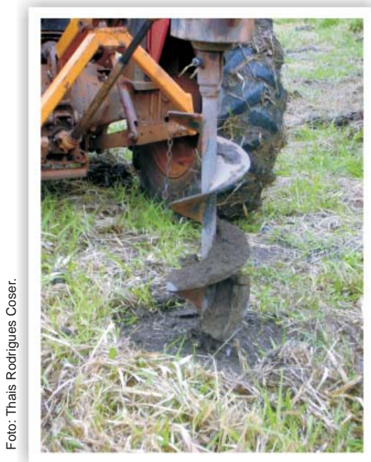
Fig. 5. Perfuratriz acoplada a um trator para abertura das covas.
