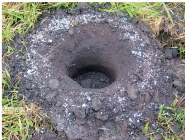
Fig. 6. Cova aberta com a utilização de perfuratriz.
