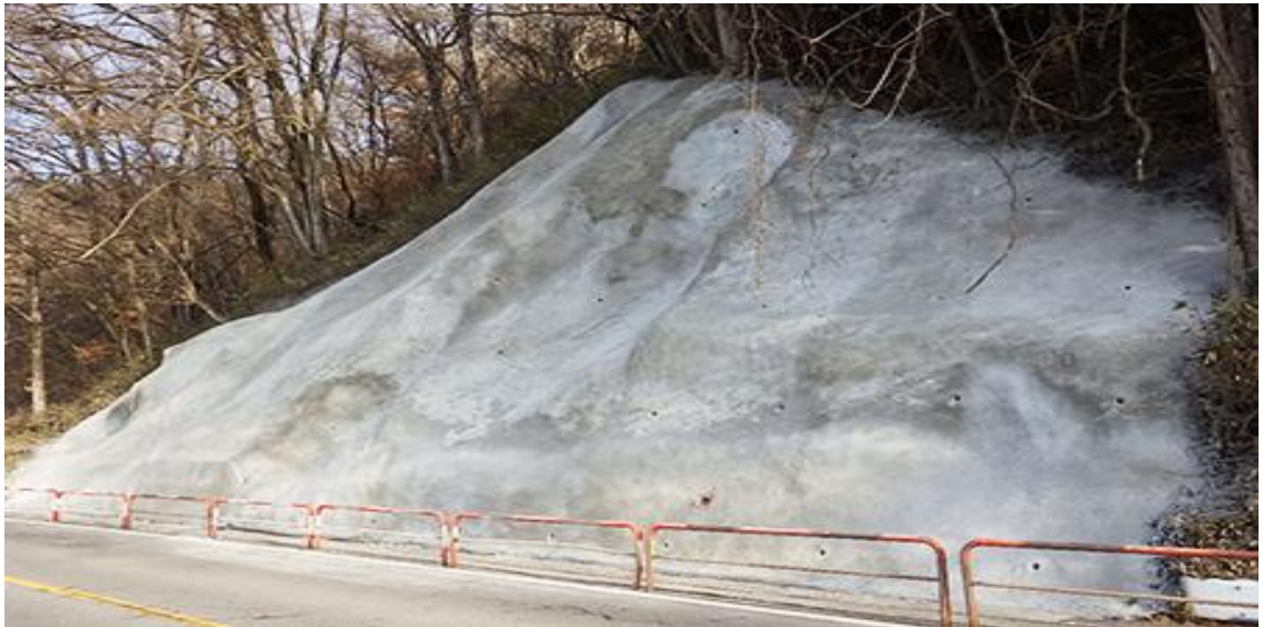
Рис. 4. Защита дороги бетонным покрытием.
