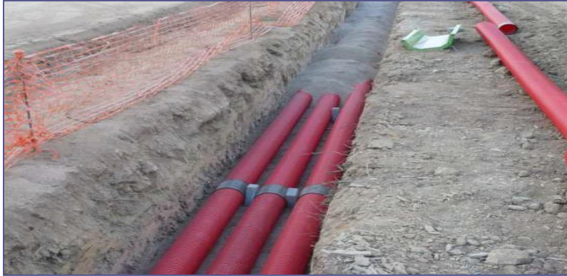
Ilustración 17. Tipo de excavación
