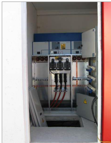
Ilustración 29. Celda de línea y celda de protección con fusible
