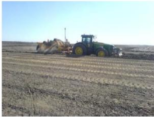
Desbroce mediante tractor
