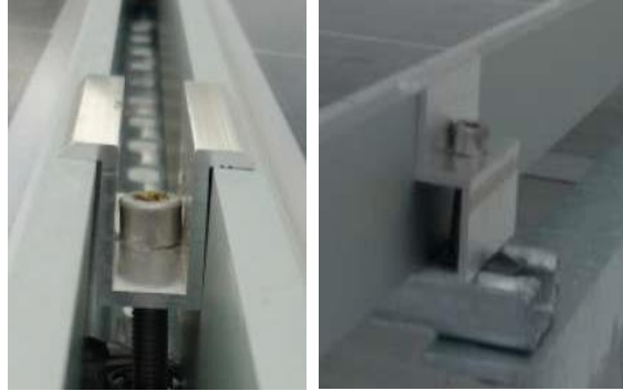
Ilustración 21. Grapas de sujeción de módulos fotovoltaicos (intermedia y final)
