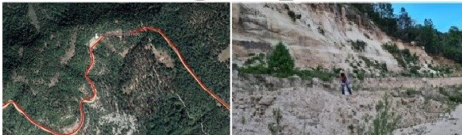
Imagen 2.20 Banco de material para capa sub rasante y terraplén
