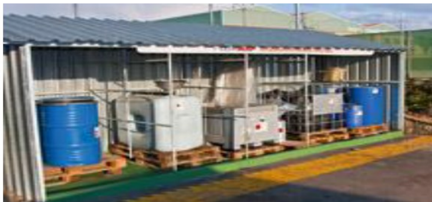
Imagen 6.17 Ejemplo de sitio de almacenamiento de los residuos peligrosos
