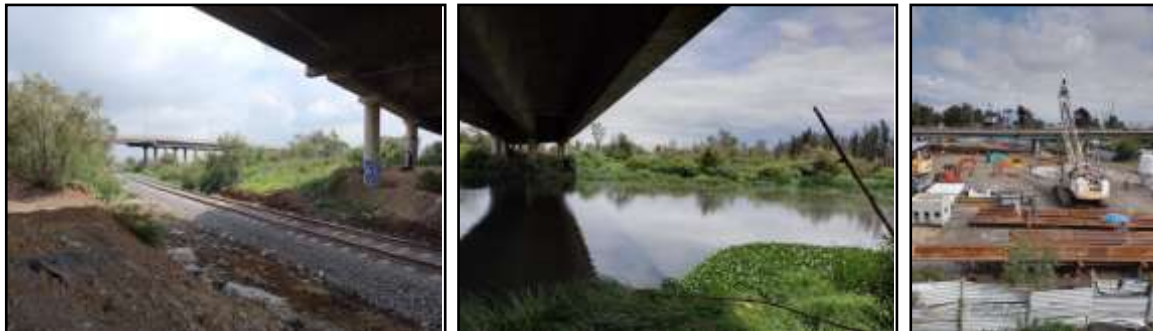
Figura II-14. Características actuales de puente vehicular.
