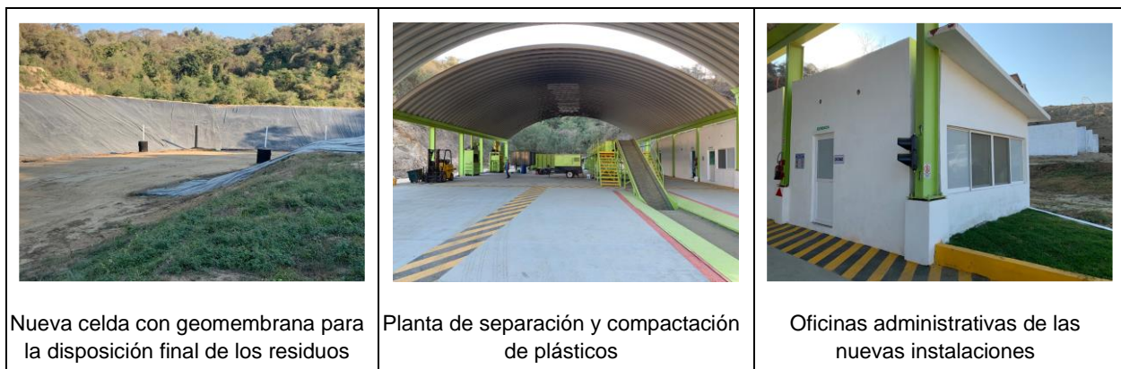
Figura 80. Vistas de la nueva celda, así como la planta de separación y compactación de residuos y las oficinas administrativas
