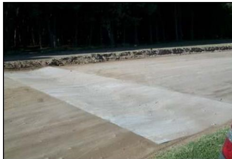
Figura II.7. Ejemplo de badén revestido de hormigón
