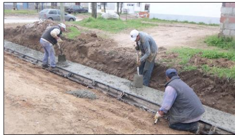
Figura II.6. Ejemplo de revestido de cunetas
