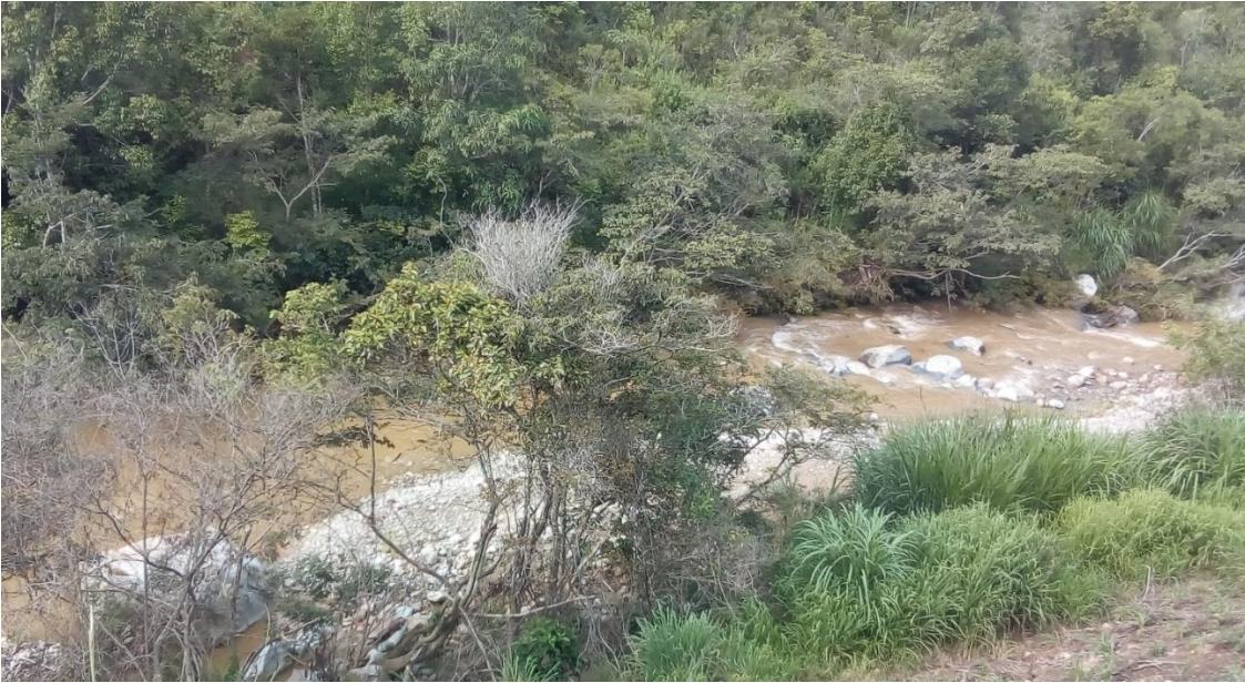
Imagen 1. Sitio de Cruce. Puente Vehicular “Porvenir Ballesteros”
