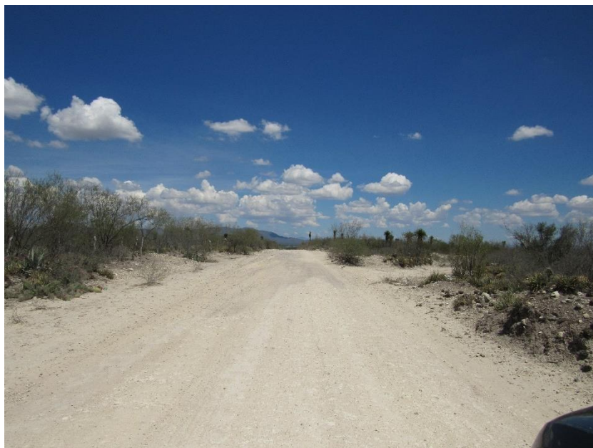
Figura 104. Aspecto general del camino, aproximadamente en el Km 18+000, hacia adelante, ligera afectación en las colindancias, zona de los polígonos de afectación 58B y 60B, afectación sobre Vegetación Secundaria arbustiva de Matorral Submontano (VSA MSM)
