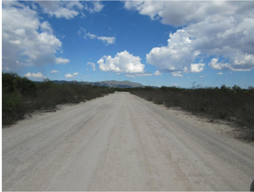
Figura 110. Aspecto general del camino, aproximadamente en el Km 22+000, hacia adelante, ligera afectación, zona del polígono de afectación 77B (Lado derecho), afectación sobre Vegetación Secundaria arbustiva de Matorral Submontano (VSa MSM)
