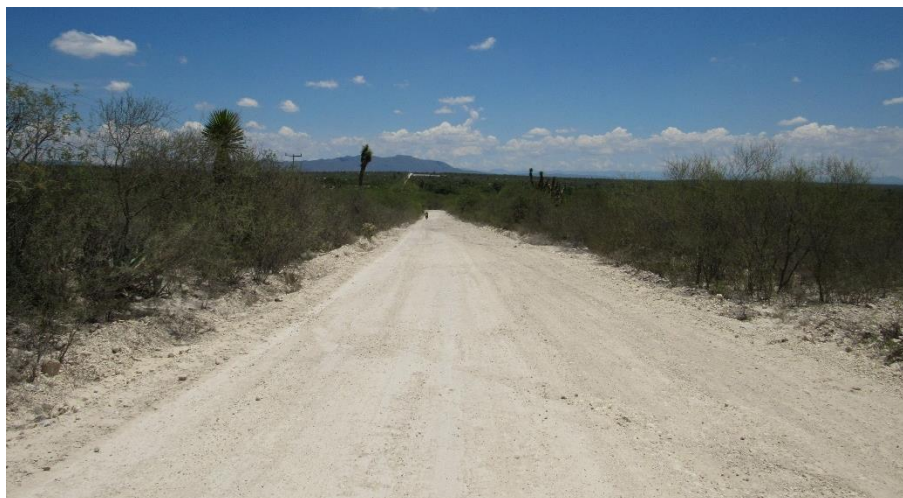
Figura 101. Aspecto general del camino, aproximadamente en el Km 15+400, hacia atrás, ligera afectación en las colindancias, zona de los polígonos de afectación 39B y 42B, afectación sobre Vegetación Secundaria arbustiva de Matorral Submontano (VSA MSM)
