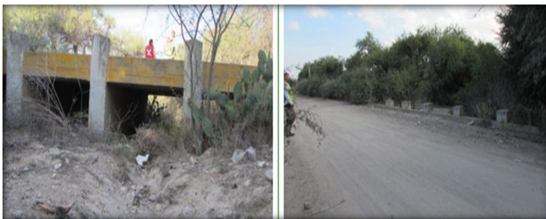
Figura 7. Condiciones del puente localizado en el km 8+971.39.
