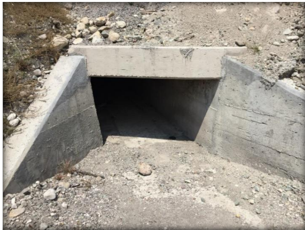
Figura 3. Ejemplo de paso inferior adaptado para especies faunísticas medianas.
