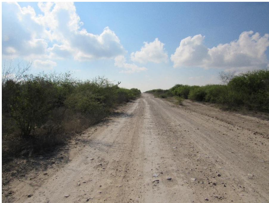
Figura 93. Aspecto general del camino, aproximadamente en el Km 10+600, hacia adelante, afectación en las colindancias, zona de los polígonos de afectación 19B y 20B
