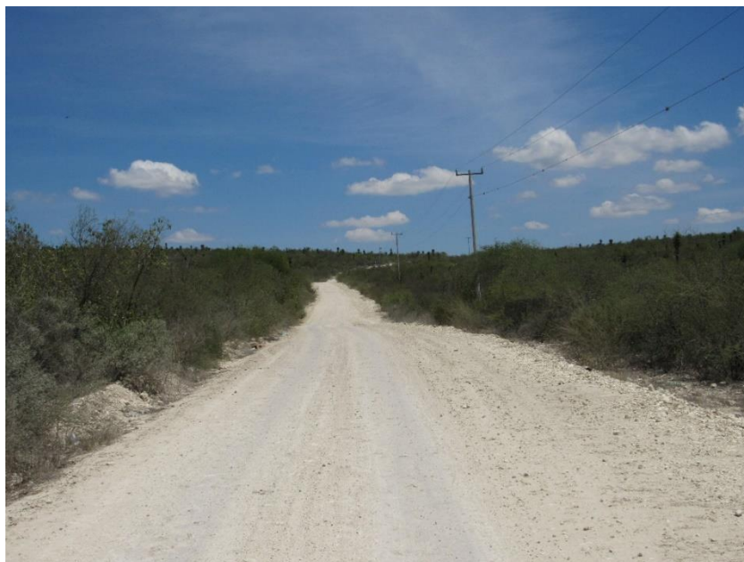
Figura 99. Aspecto general del camino, aproximadamente en el Km 14+140, hacia adelante, ligera afectación en las colindancias, zona de los polígonos de afectación 37B y 38B, afectación sobre Vegetación Secundaria arbustiva de Matorral Submontano (VSa MSM)
