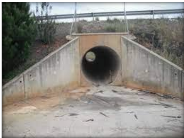
Figura 2. Obra de drenaje compuesta por un tubo de lámina de 1.20 m de diámetro.
