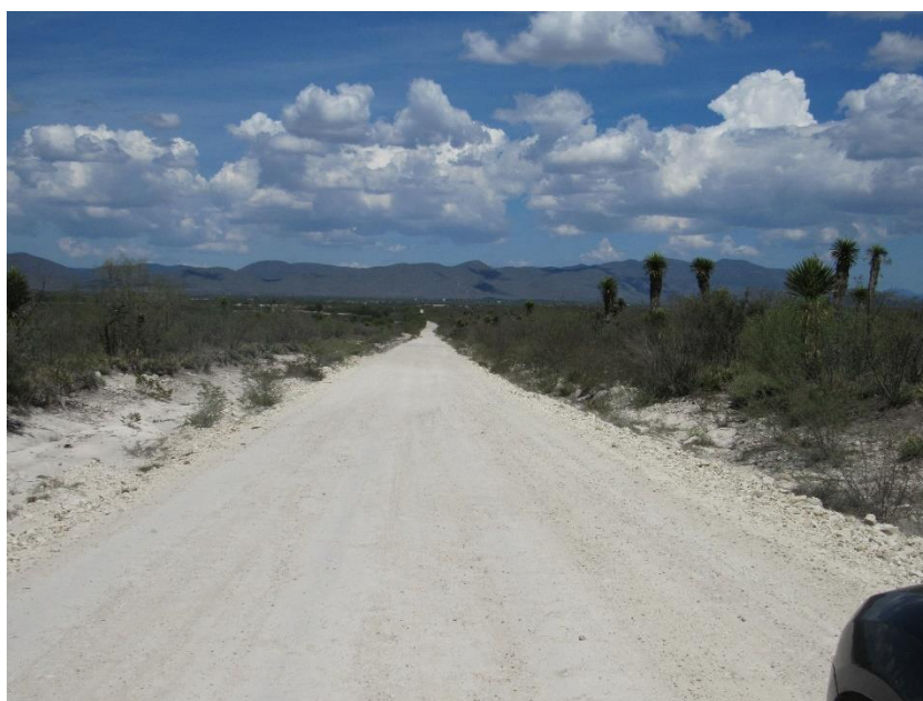
Figura 105. Aspecto general del camino, aproximadamente en el Km 18+800, hacia adelante, ligera afectación en las colindancias, zona de los polígonos de afectación 61B y 62B, afectación sobre Vegetación Secundaria arbustiva de Matorral Submontano (VSA MSM)
