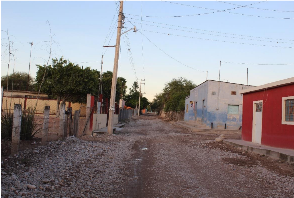
Figura 27. Vista general de las características de la zona donde inicia el camino del Ramal a Manzanillas (km 1+508.64) (Vista hacia adelante).
