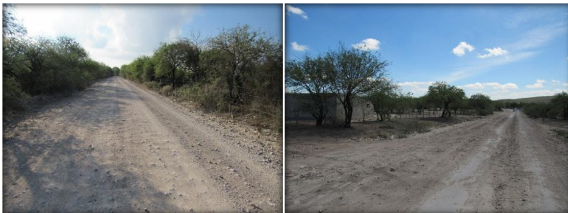
Figura 6. Aspecto general del camino Cerritos - Granjenal del km 8+600 al km 22+161.35.
