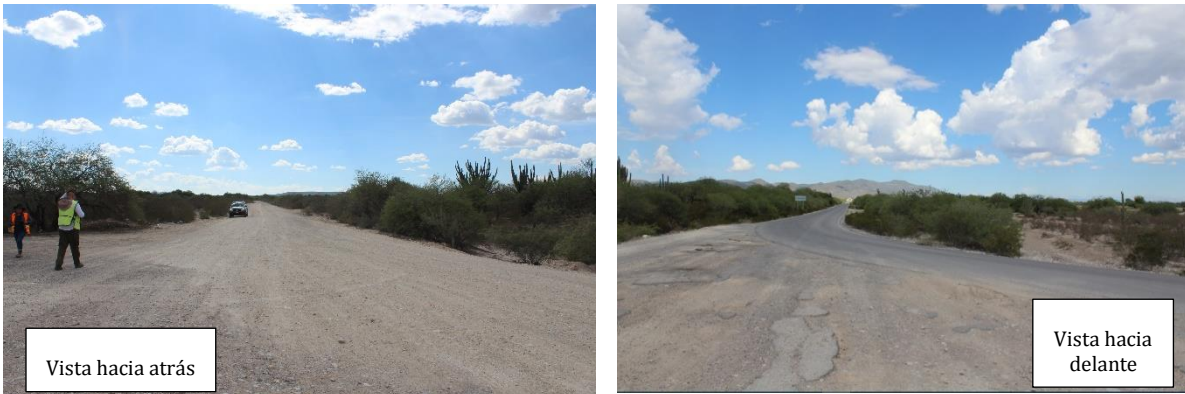
Figura 14. Fin del camino en el km 22+161.35, donde se entronca con un camino pavimentado el cual llega a la localidad de Granjenal.
