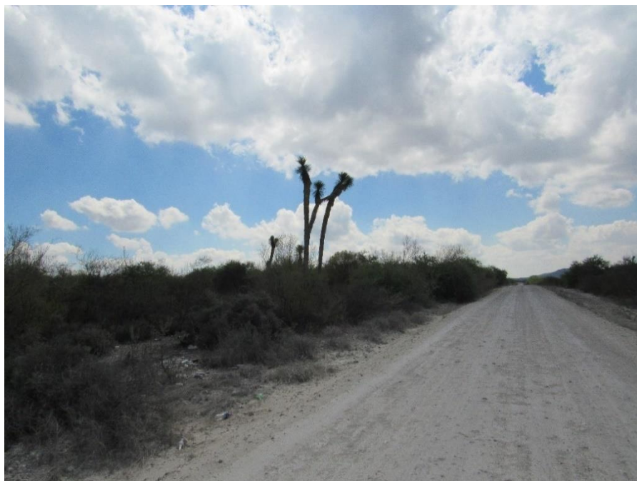
Figura 94. Aspecto general del camino, aproximadamente en el Km 11+000, hacia adelante, ligera afectación en las colindancias, zona de los polígonos de afectación 20B y 22B
