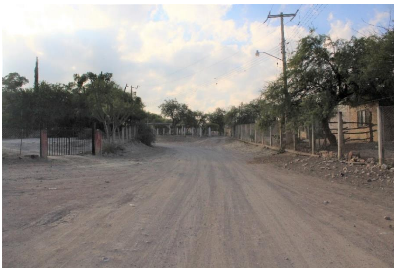
Figura 24. Vista general de las características de la zona donde inicia el camino Cerritos – Granjenal (km 8+600) (Vista hacia delante)
