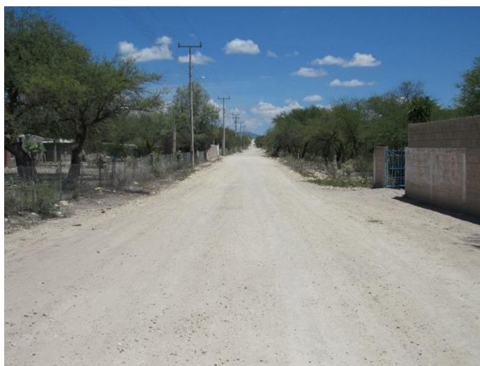
Figura 103. Aspecto general del camino, aproximadamente en el Km 16+800, hacia adelante, zona catalogada como asentamientos humanos, localidad La Cardona, por lo que la afectación a cubierta vegetal de importancia es nula
