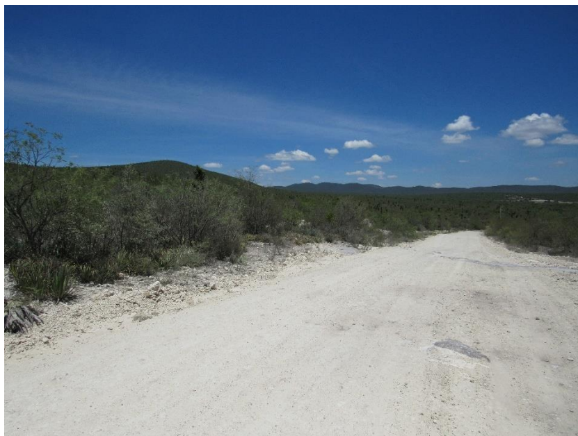
Figura 100. Aspecto general del camino, aproximadamente en el Km 15+200, hacia adelante, ligera afectación en las colindancias, zona de los polígonos de afectación 39B y 41B, afectación sobre Vegetación Secundaria arbustiva de Matorral Submontano (VSA MSM)
