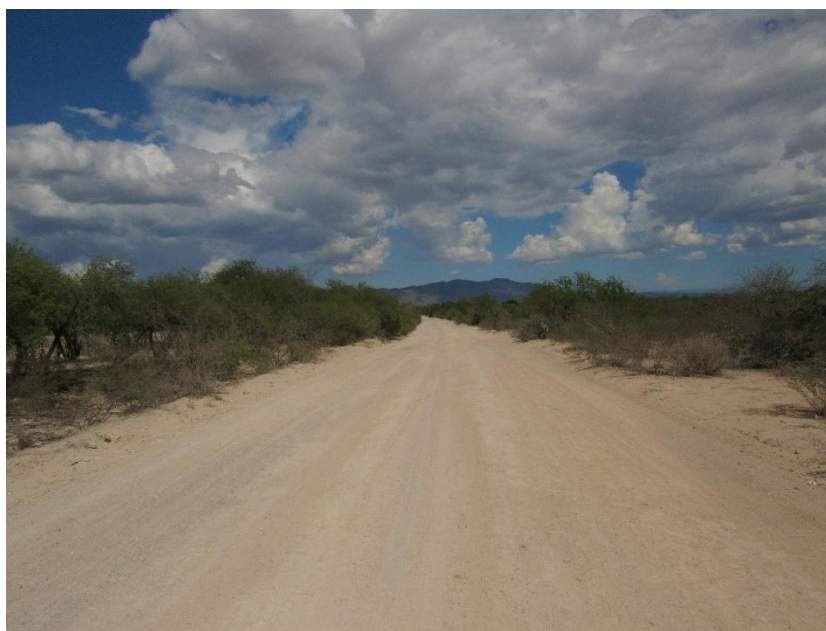
Figura 109. Aspecto general del camino, aproximadamente en el Km 21+200, hacia adelante, ligera afectación, zona de los polígonos de afectación 73B y 74B, afectación sobre Vegetación Secundaria arbustiva de Matorral Submontano (VSa MSM)
