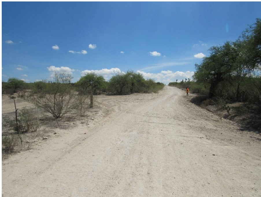
Figura 96. Aspecto general del camino, aproximadamente en el Km 12+200, hacia adelante, ligera afectación en las colindancias, zona de los polígonos de afectación 26B y 27B
