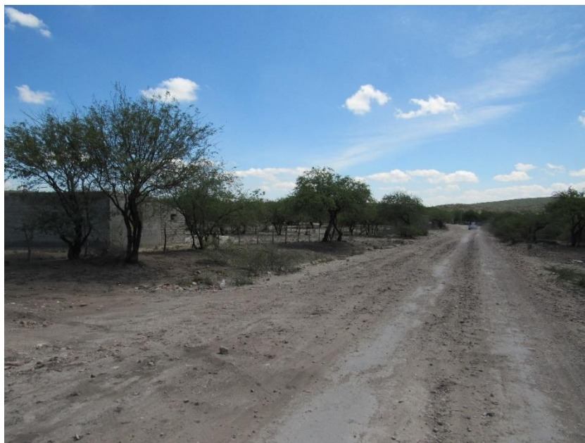
Figura 97. Aspecto general del camino, aproximadamente en el Km 12+800, hacia adelante, ligera afectación en las colindancias, zona de los polígonos de afectación 28B y 30B, inicia la zona catalogada como asentamientos humanos, localidad Cerrito Blanco, por lo que la afectación a cubierta vegetal de importancia es nula
