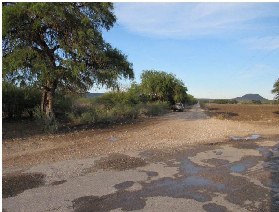
Figura 78. Inicio del Ramal, el camino actual de terracería es amplio, la hilera de mezquites no se prevé que sea afectada, de aquí y hasta la entrada del poblado de Manzanillas, es de uso agrícola y pecuario en las colindancias
