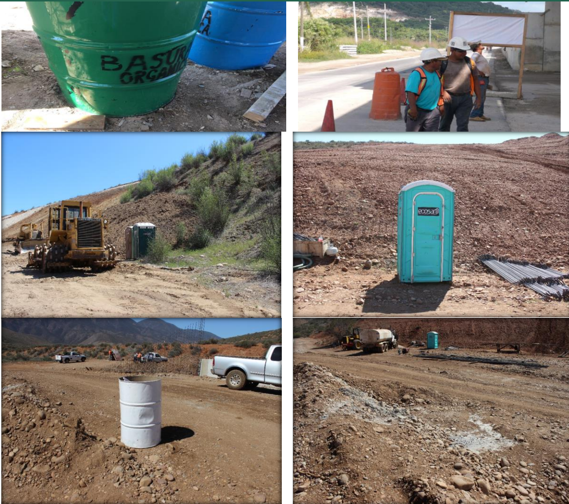
FIGURA II-14 EJEMPLO DE FRENTES DE OBRA EN PROYECTOS CARRETEROS
