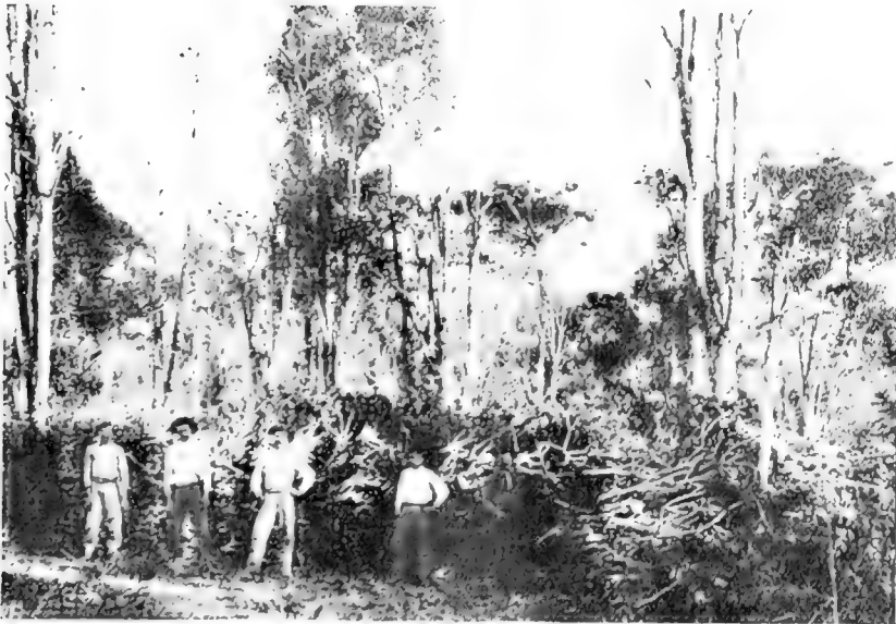
Fig. 2. — Trabajos empezando el trabajo
