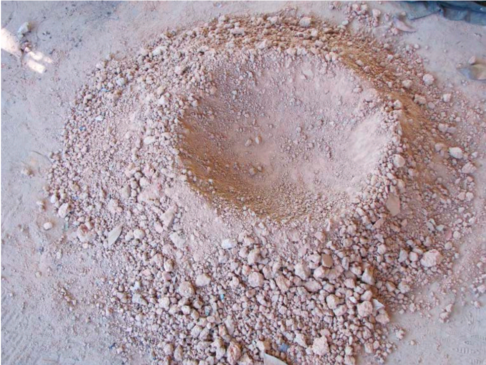
Figura 48: Molde de apoio preparado com a terra do próprio local, 2010. Foto: Jean-Jacques Vidal.
