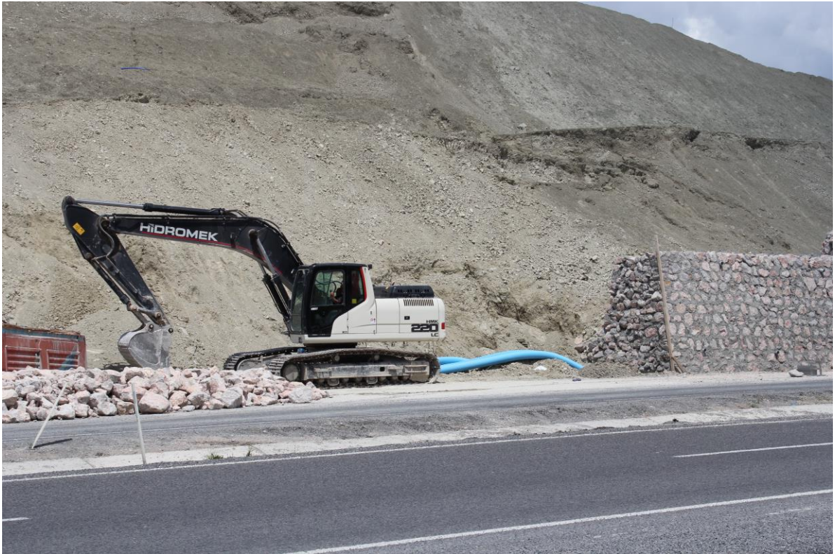
Fotoğraf 8. Beypazarı-Nallıhan karayolunun 15,5 km'sinde yolun sağındaki genişletme çalışmaları ve istinat duvarı (Foto. M.Vural).
