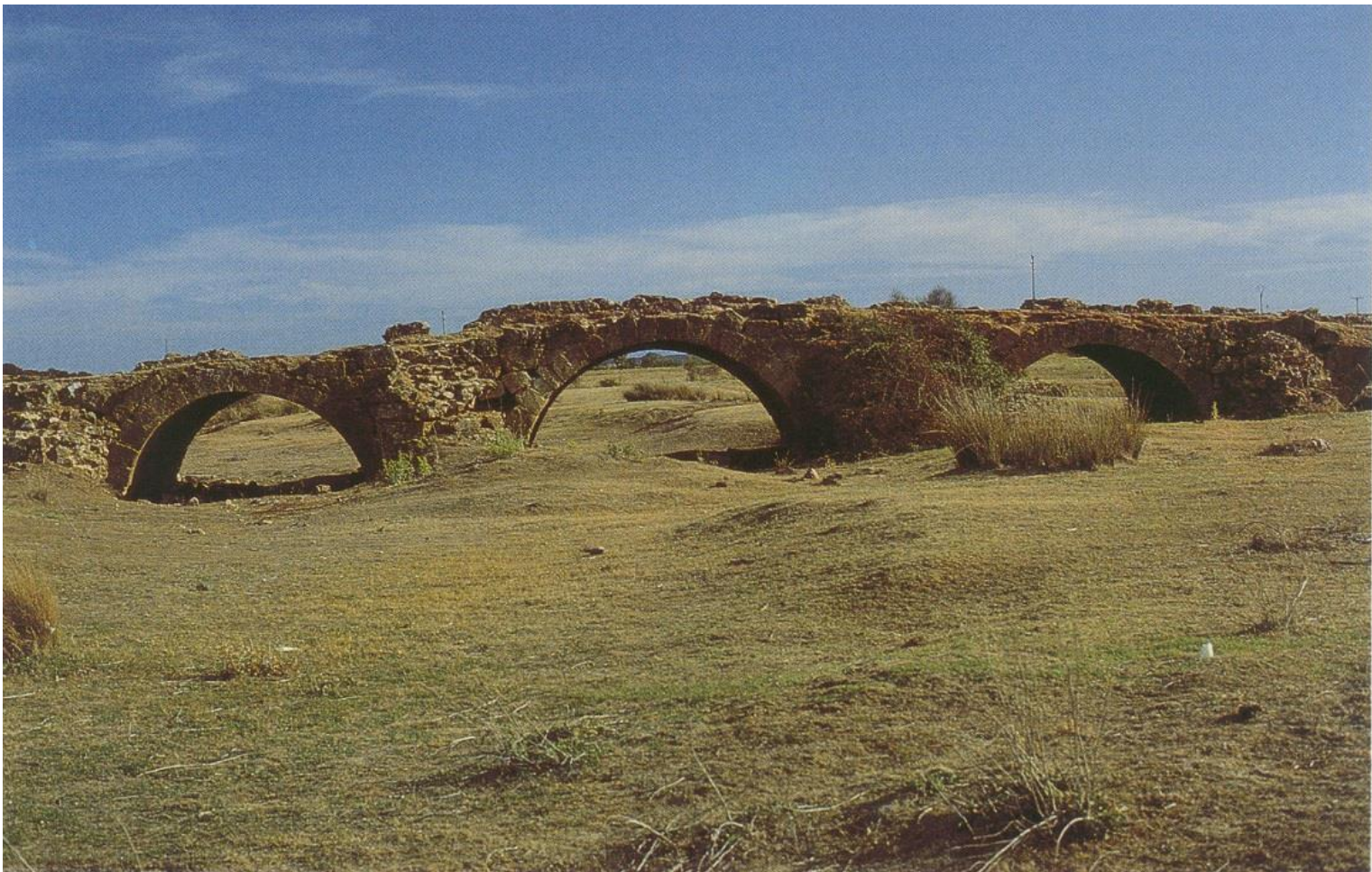
Foto 3. Bella reliquia de puente romano sobre el río La Valmuza, en la calzada de Miróbriga a Salamanca, enlace con la vía de La Plata (Mérida a Astorga) y las vías pecuarias en dirección a Medina del Campo, mercado central español más importante de ovino durante la trashumancia. Calzadilla. 1992. (Foto J. Berrocal).
