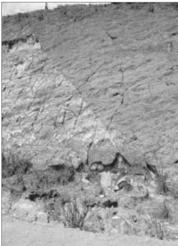
Figura 16: Corte à margem da BR-101, ao norte da cidade de Itabela, sobre a linha divisora das bacias hidrográficas dos rios Buranhém e dos Frades. A descontinuidade oblíqua corresponde à interseção do plano topográfico com o de uma falha inversa, nos sedimentos da formação Barreiras. A direção medida é N60E e o mergulho de 65° para SE. Extraído de Saadi (1996).
