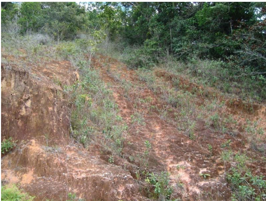
Figura 23: Corte na vertente para retirada de material para formação de barragem. Vale do rio da Barra, Porto Seguro (BA).
