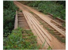
Platelage en bois d'un pont
