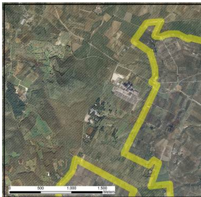
Figura 5. Il settore orientale del SIC con la struttura ospedaliera regionale "F. Miulli".
