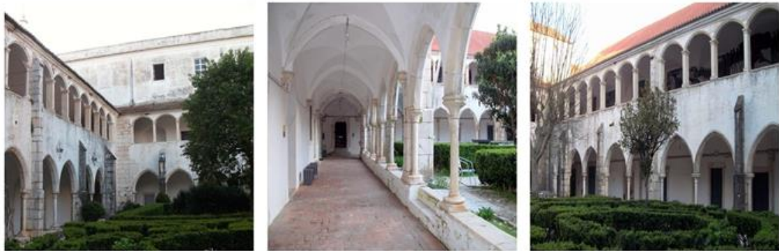
Figure V-2. The manueline architecture of the Convent of “São João da Penitência” [5] .
