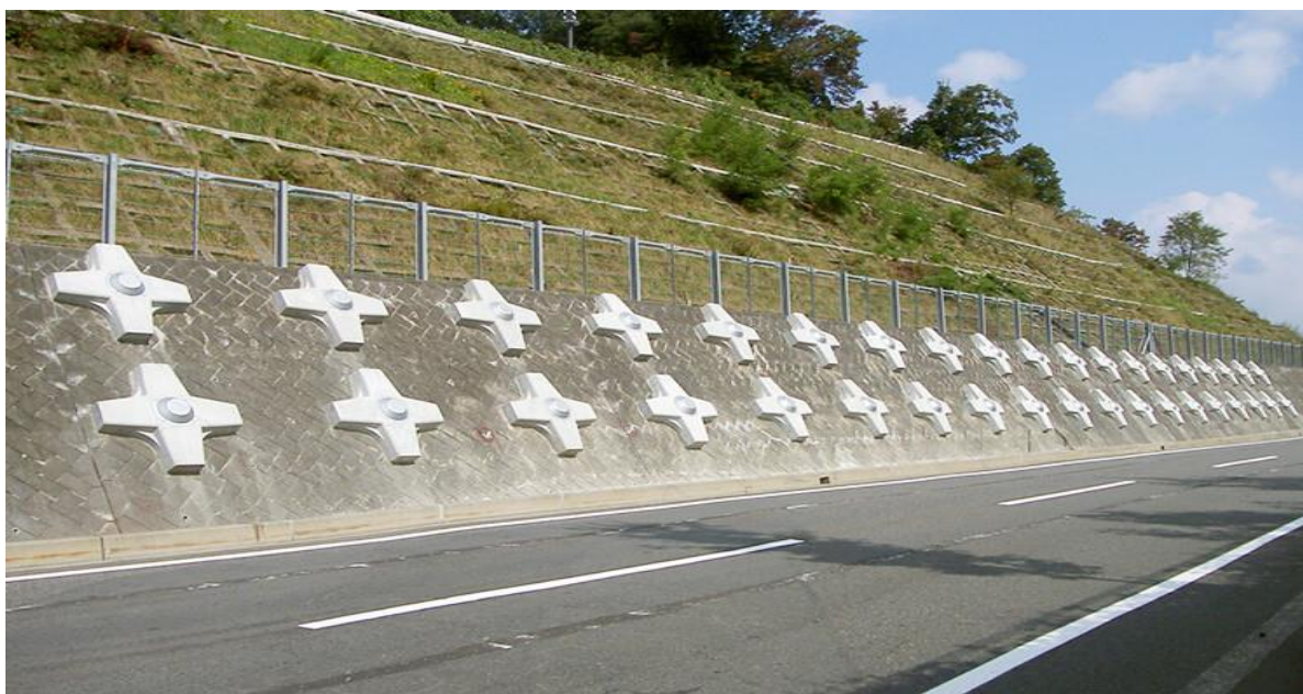
Рисунок 3. Бетонное ограждение, построенное для защиты дороги от эрозии и стихийных бедствий.[8]
