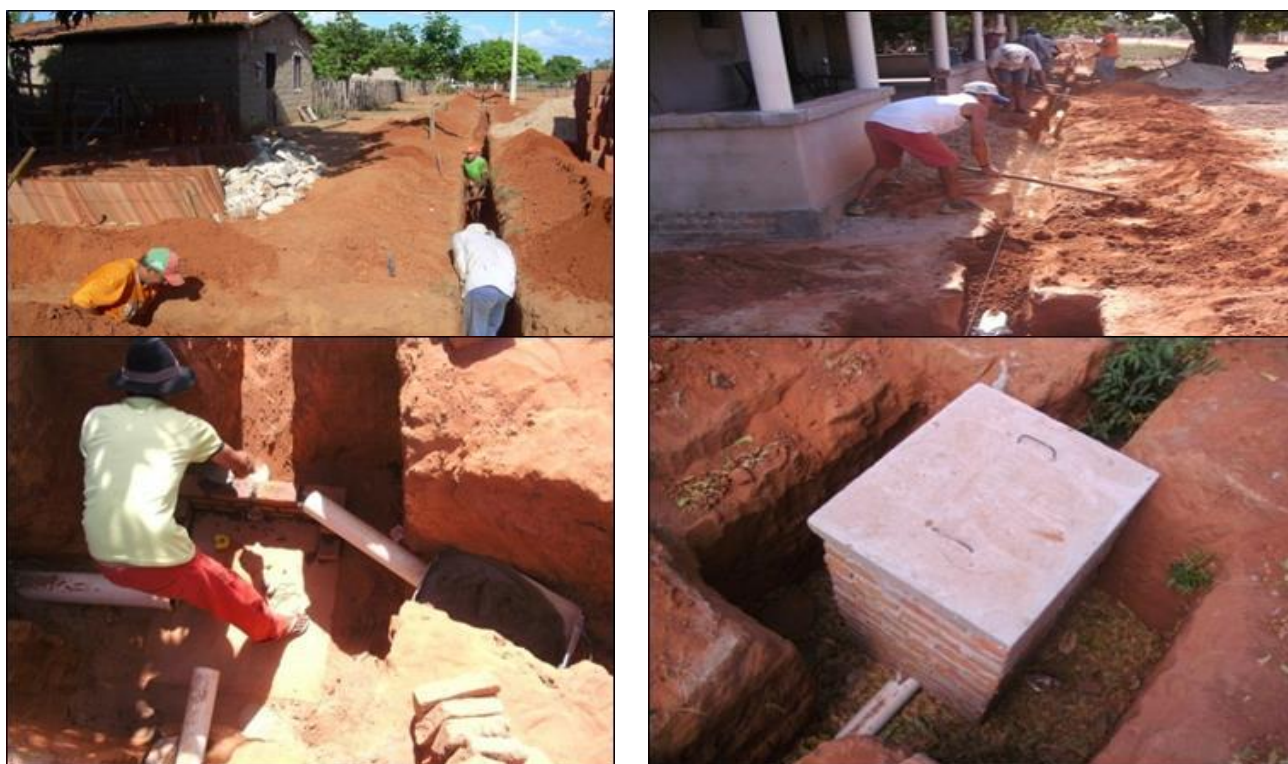
Figura 3. Escavação das valetas e disposição dos tubos adutores de esgoto construído pelos assentados. Fonte: Dados do acervo de pesquisa.
