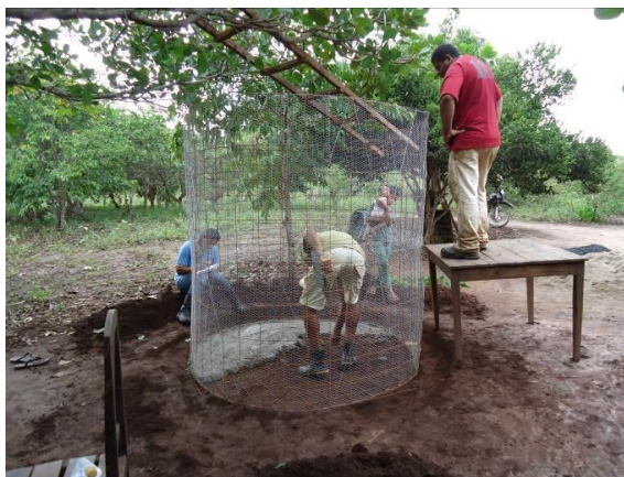
Figura 1. Construção de cisterna de ferrocimento no Assentamento Maria Preta, Araçagi-PB.
