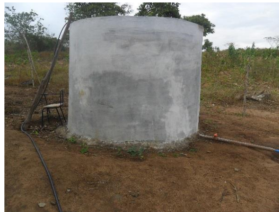
Figura 1. Construção de cisterna de ferrocimento no Assentamento Maria Preta, Araçagi-PB.
