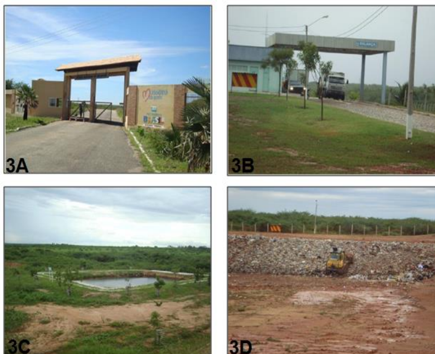
Figura 3. 3 A: fachada do ASCM; 3 B: balança do ASCM; 3 C: lagoa de tratamento percolado; 3 D: operação na célula.
