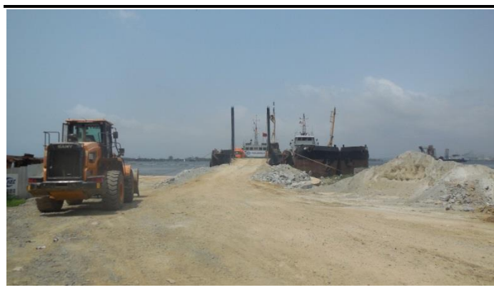
Figure 0.2 Quai de déchargement existant de la CHEC près du site du Projet
