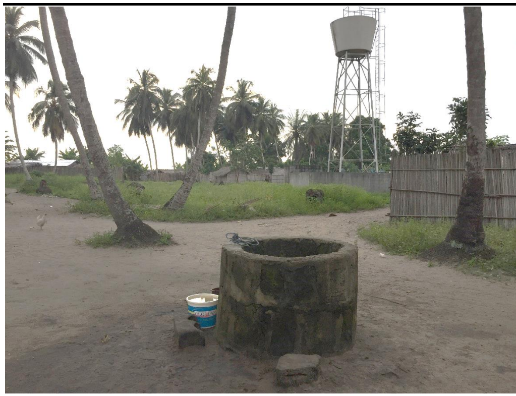
Figure 6.39 Vue du château d'eau à Taboth
