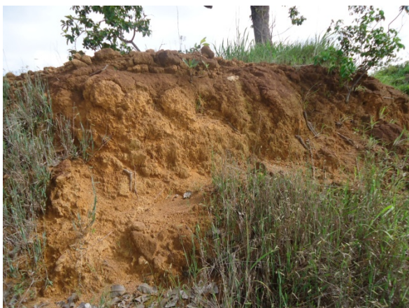
Foto 09: Talude originado de escavações pretéritas para obtenção de cascalho que necessitam agora ser suavizados. Coordenadas UTM 22K Sirgas 2000 E: 667416 N: 8146524
