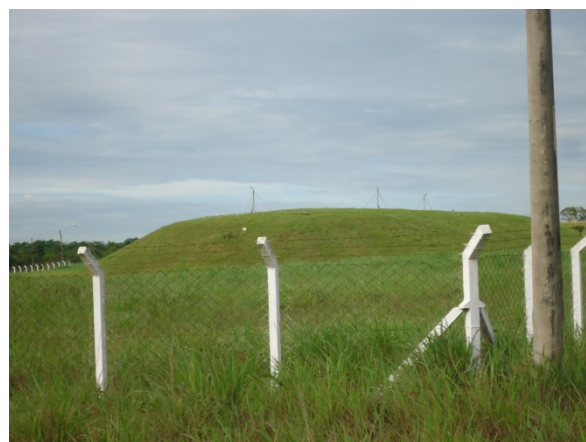
Foto 02: Depósito definitivo dos resíduos do acidente com o Césio-137. Coordenadas UTM 22K Sirgas 2000 - E: 668180 N: 8146835
