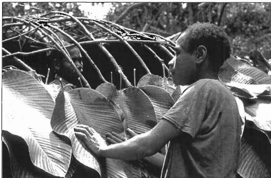
Photo 12 : Construction d'une hutte hémisphérique chez les Pygmées Baka, sud Cameroun. Tuiles végétales en feuilles de Megaphrynium macrostachyum (Marantaceae).
