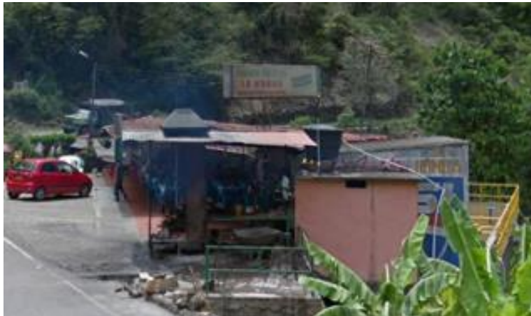
Fotografía 8.26 Restaurantes localizados en la vía existente – Sector La Honda
