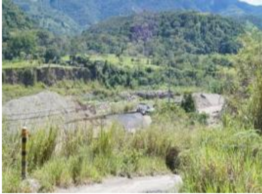
Fotografía 8.8 Extracción de materiales de construcción E: 1158743 N: 1329954
