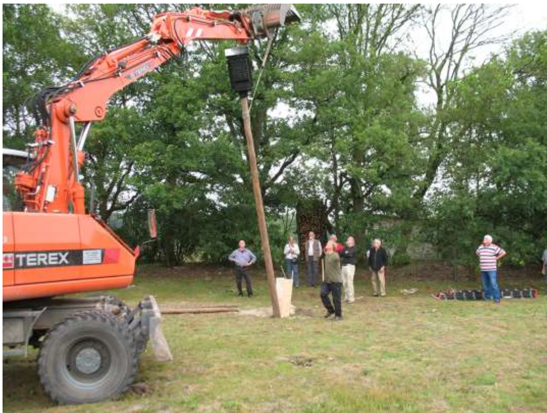
Figuur 10. De paalkast achter de Hut van Homberg wordt geplant (foto Erik Korsten).
