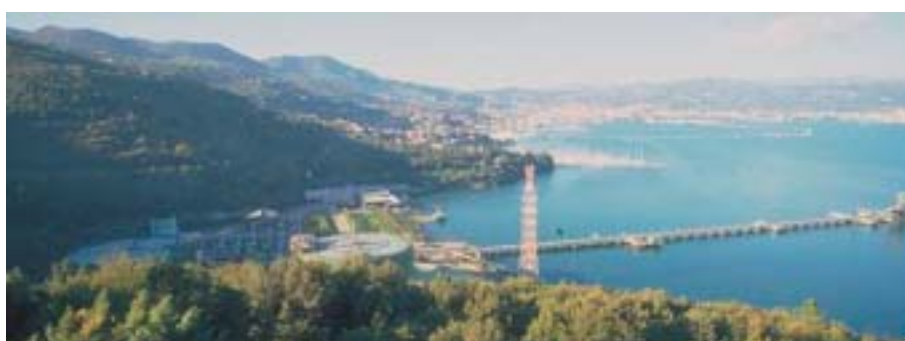
Figura 6 - Lo stabilimento nel 1998 dopo l'intervento di riqualificazione paesistico-ambientale.
