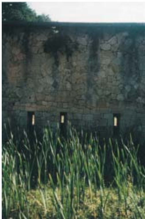
Figura 10 - Fessure di luce nel bastione di San Bernardino. Il tufo, con paramenti ad opus polygonale , di accuratissimo taglio, messo in opera nella complessa sequenza dei muri alla Carnot, è il contrassegno stilistico della fortificazione asburgica, che risalta per il bellissimo colore dorato, sui fondali erbosi.
