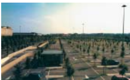
Figura 17 - L'ampliamento del parcheggio in superficie verso ferrovia.
