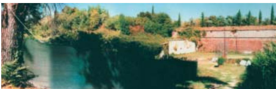
Figura 5 - Il bastione asburgico di San Procolo assediato dalla vegetazione. Sono iniziati i lavori di diradamento.
