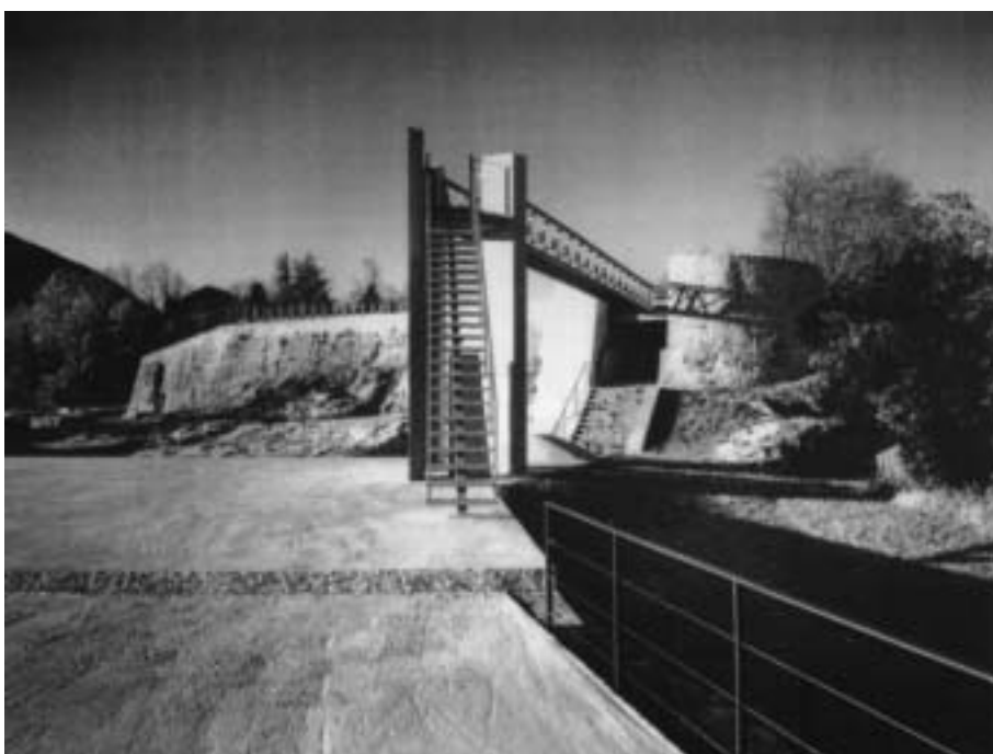
Figura 8 - Il monumento, il ponte e la scala da sud.
