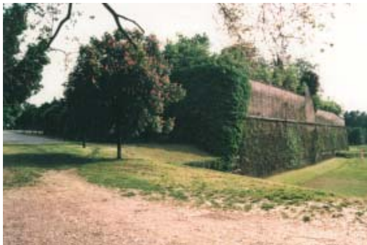
Figura 11 - Le Mura veneziane: la cortina di S. Procolo. Fosso magistrale, controscarpa del fosso, spalto, conformano il vuoto prospettico all'esterno della cortina.
