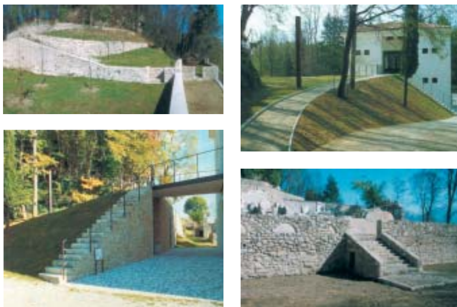
Figura 10 - I terrazzamenti del colle di Napoleone, il terrapieno della Casa del Comandante e il centro visite dopo gli interventi di recupero.
