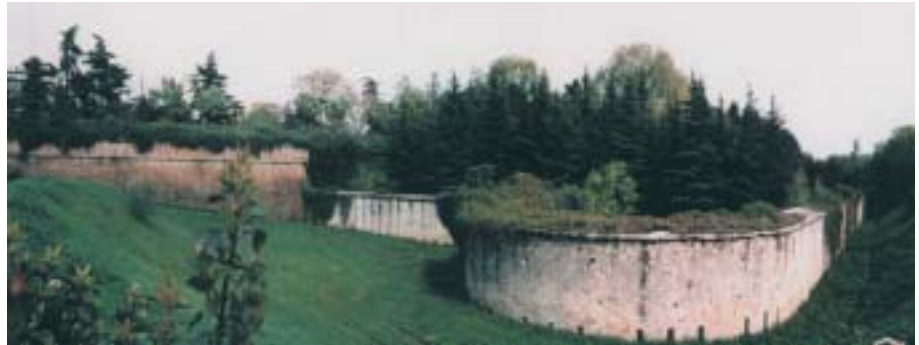
Figura 6 - Il muro veneziano, l'orecchione austriaco e il vallo del bastione dei Riformati. La vegetazione invade il bastione negando l'opera.
