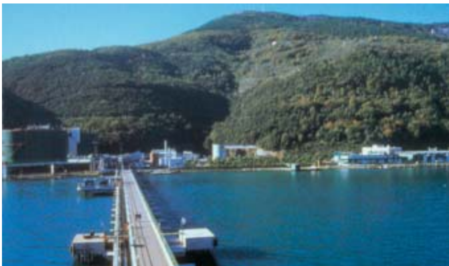
Figura 1 - Veduta dello stabilimento dal mare.
