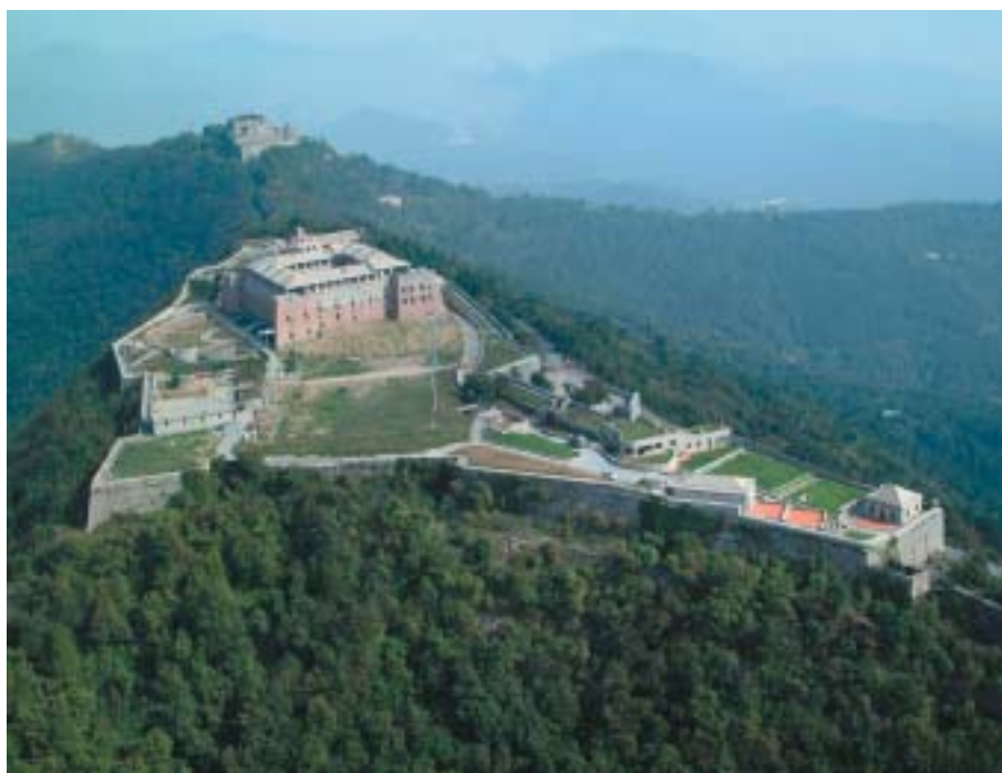
Figura 12 - Forte Begato con la sistemazione degli spazi aperti: veduta aerea.
