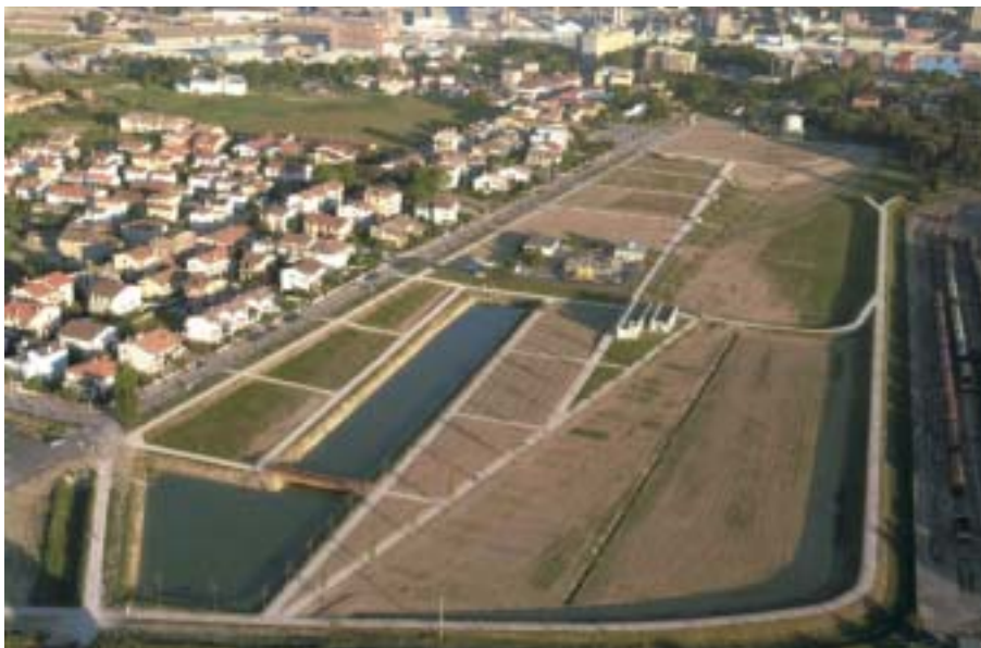
Figura 12 - Il Parco di Teodorico (a realizzazione ultimata del primo stralcio).
