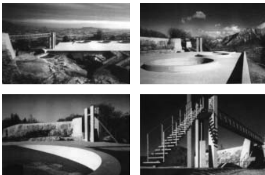
Figura 6 - Il Castel novo, il ponte con la scala, il monumento e il piazzale delle cupole.
