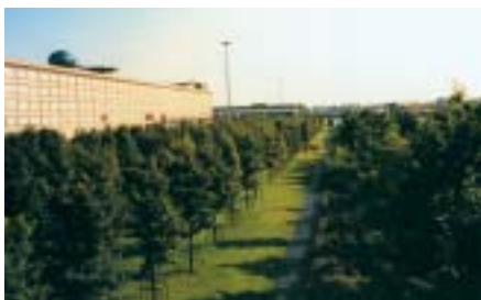
Figura 11 - Veduta del fronte posteriore (in evidenza l'eliporto).
