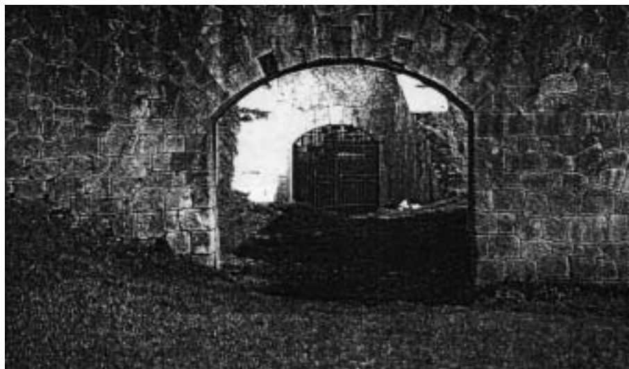
Figura 20 - Nell'illuminazione notturna, i muri distaccati alla Carnot , con la sequenza delle nicchie archeggiate sull'interno perimetro dei bastioni, risalteranno per la loro bellezza architettonica. Saranno inoltre l'elemento conduttore del percorso interno, dalle poterne , lungo il cammino di ronda.
