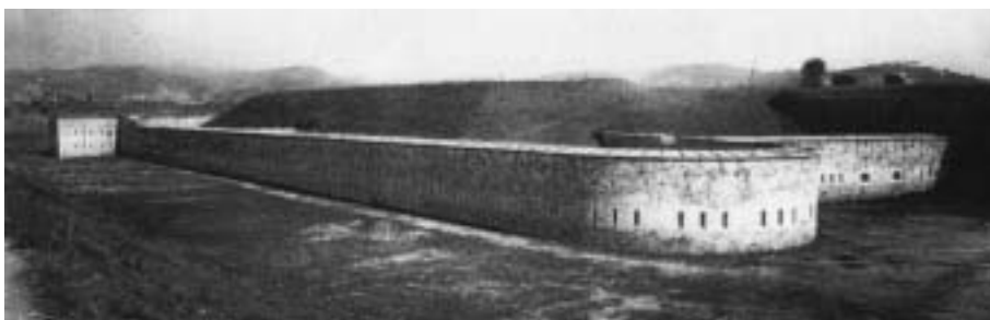
Figura 4 - Il bastione asburgico di San Procolo in una fotografia dell'anno 1940.
