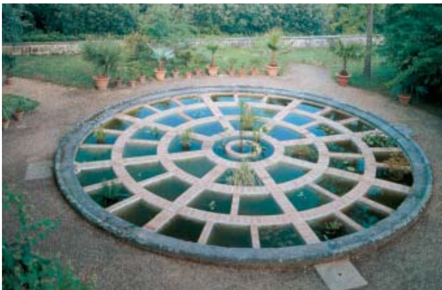
Figure 8-9 - L' Aquarium del Giardino Superiore della Botanica, prima e dopo gli interventi di restauro effettuati dal 1994 al 1996.
